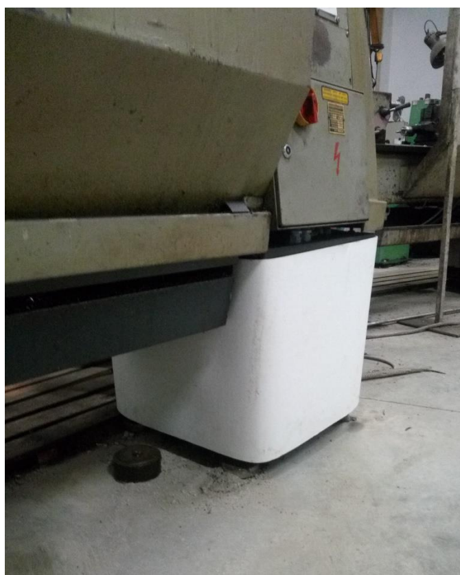
Figura 50 - Parte inferior (caixa do motor) depois do isolamento
