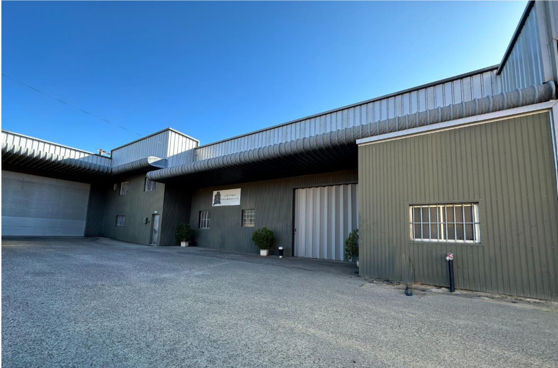
Imagem 2 - Sede e instalações Santos & Bairros, Lda.
