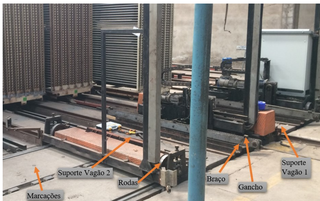
Figura 61 – Vista do transportador 2
