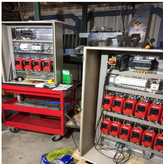
Figura 26 – Montagem dos quadros elétricos do sistema automático de transporte de caixas
