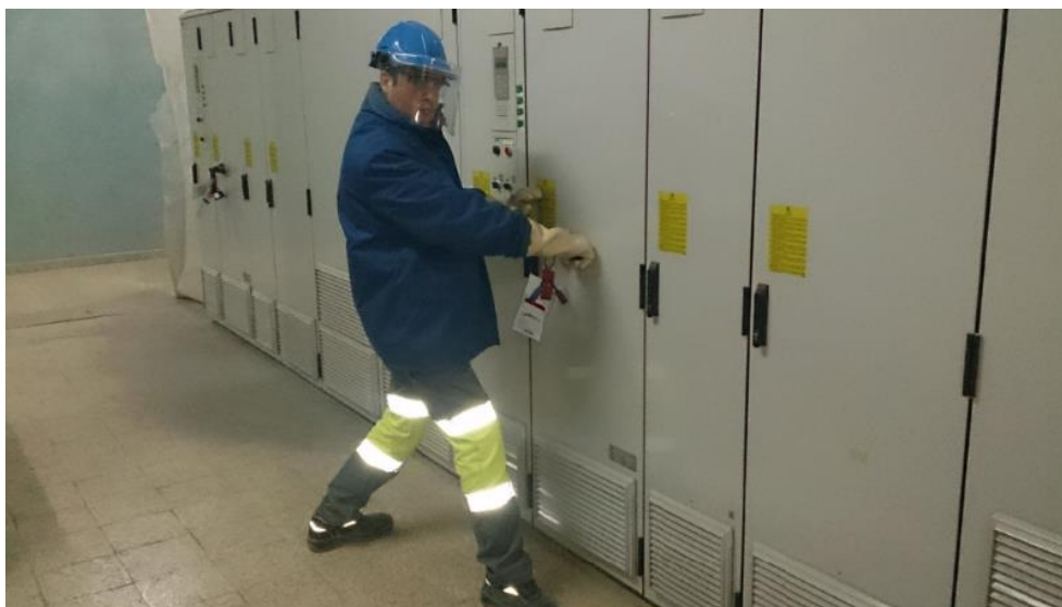
Figura 58: Eletricista a proceder ao corte de energia [Fonte: Cimpor]
