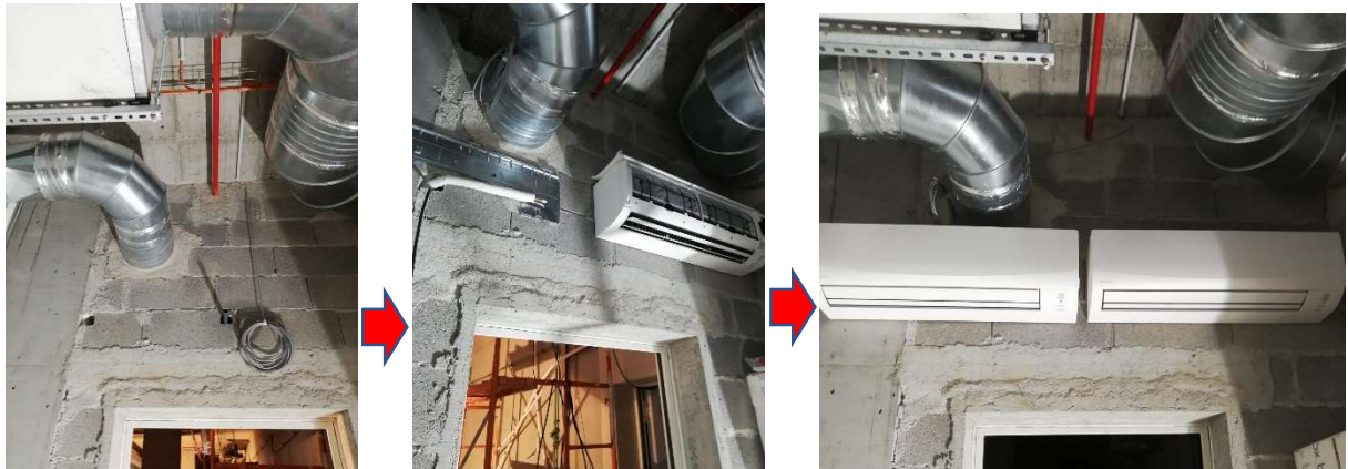
Figura 8 - Instalação de AC
