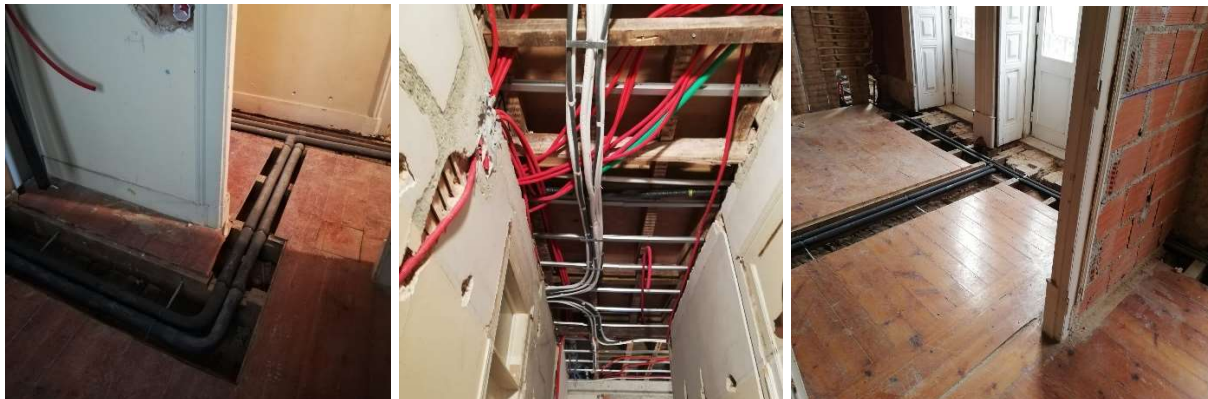
Figura 6 – Instalação de redes hidráulicas e de AC numa moradia em Cascais
