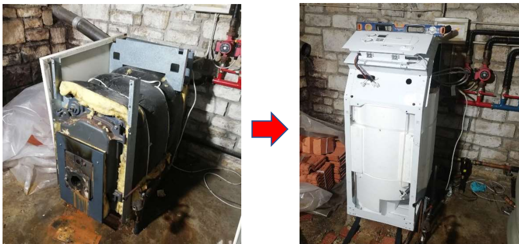
Figura 9 - Substituição de caldeira
