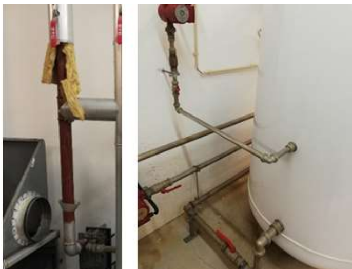
Figura 23 - Isolamento danificado
