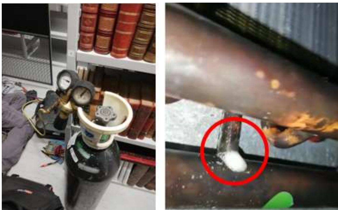
Figura 4 – Detecção e reparação de fugas
