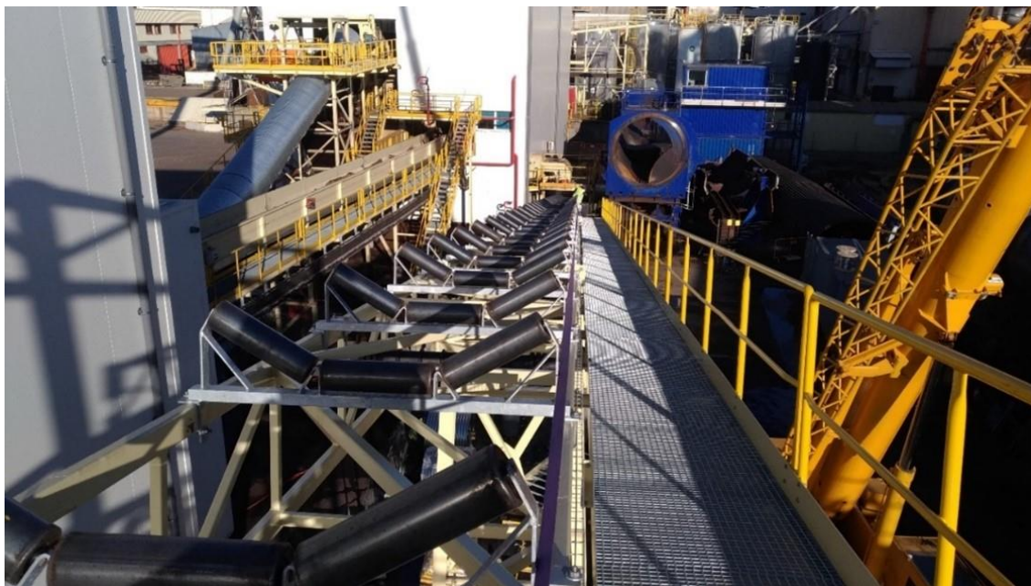
Figura 87 - Finalização da montagem estrutural do transportador.
