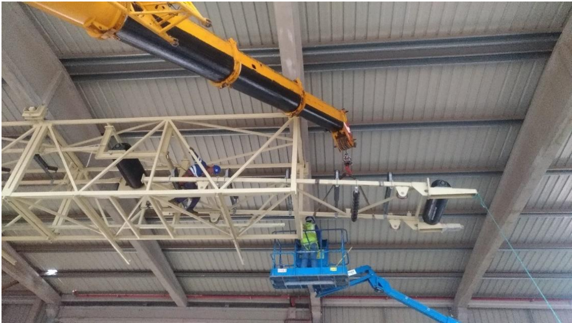
Figura 85 - Início de instalação do transportador móvel.
