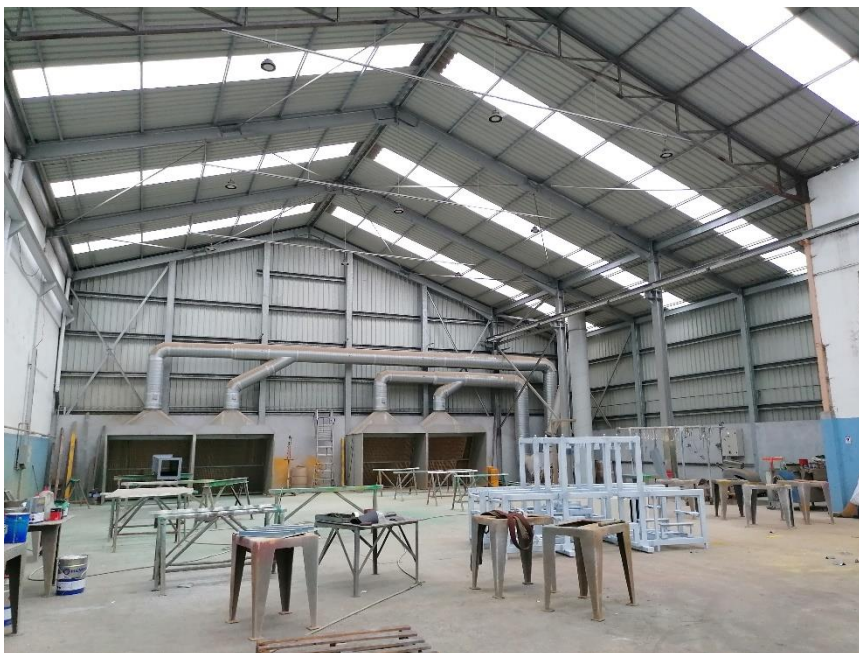
Figura 5 - Zona atual de pintura no terceiro pavilhão.
