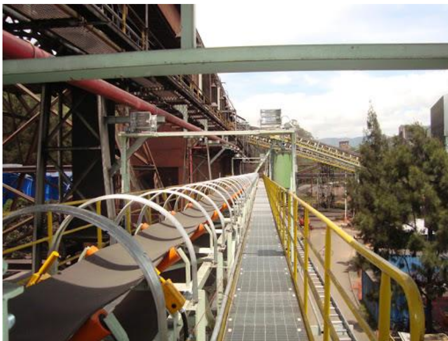
Figura 29 - Acesso adequado através de passadiço com proteção lateral (APEquipamentos, 2021).
