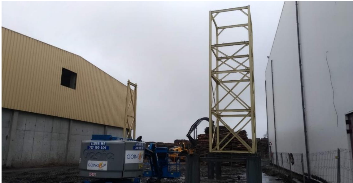
Figura 81 - Instalação de Torre e Pilares metálicos
