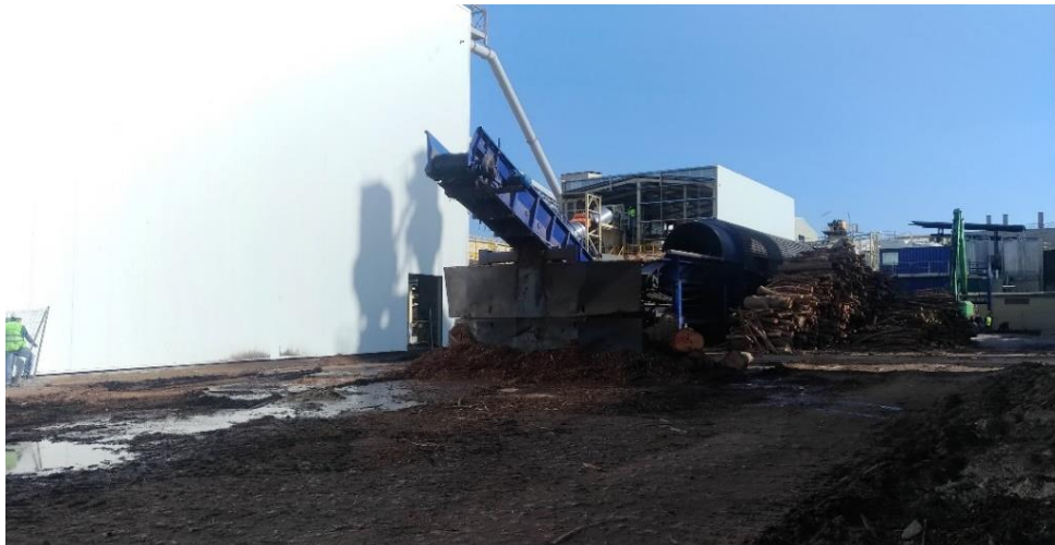
Figura 33 - Zona de recolha do material a transportar.
