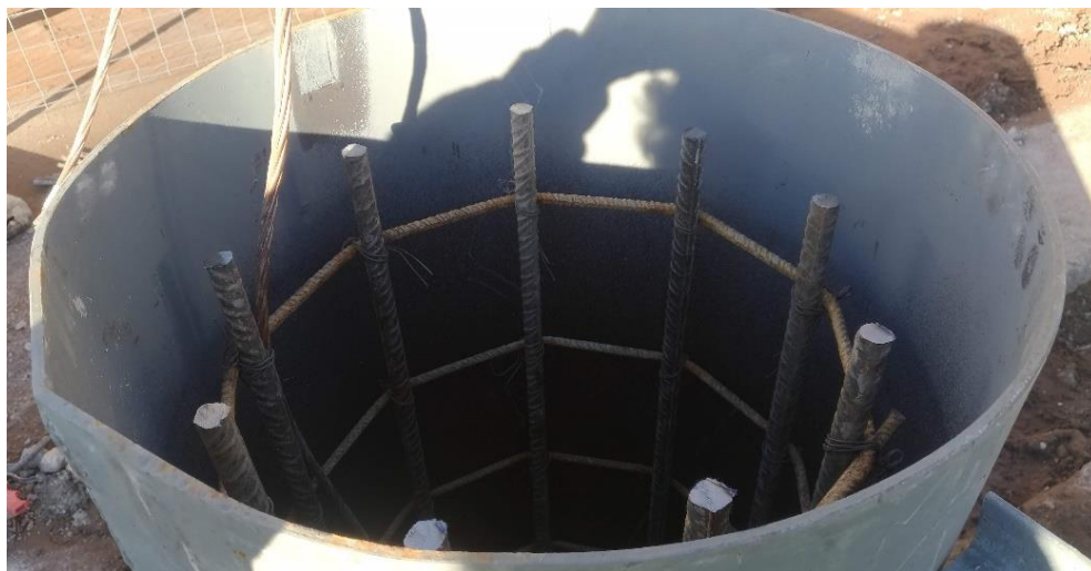
Figura 80 - Colocação de tubo em aço para construção de pilares em betão
