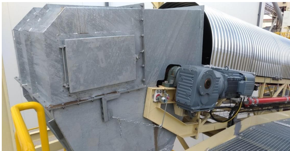
Figura 91 - Tremonha de descarga com porta de visita.
