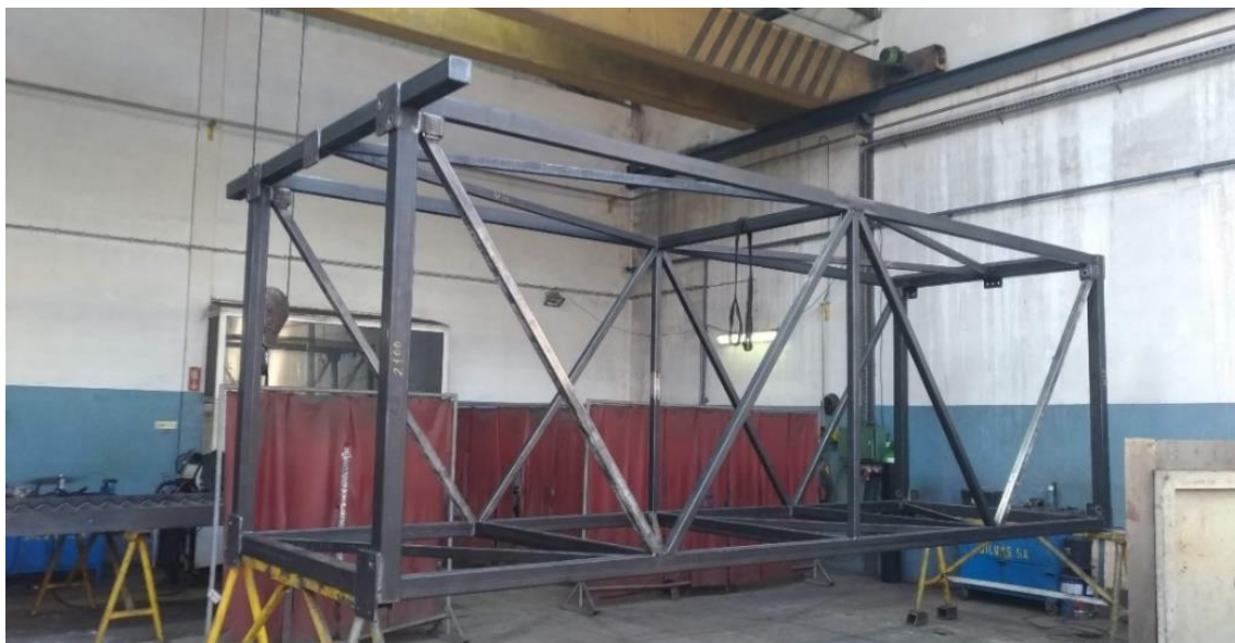
Figura 76 - Galeria em processo de soldadura.
