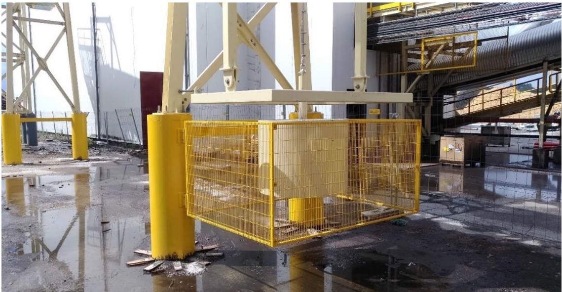
Figura 94 - Gradeamento envolvente de contrapeso para proteção
