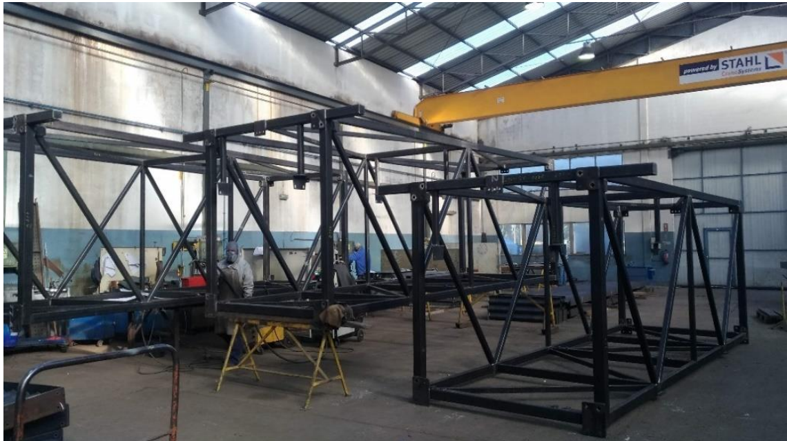
Figura 77 - Galerias em espera por validação e acabamento superficial.
