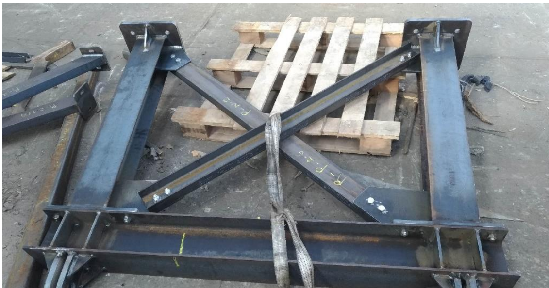
Figura 75 - Suporte finalizado aguardar por processo de acabamento.
