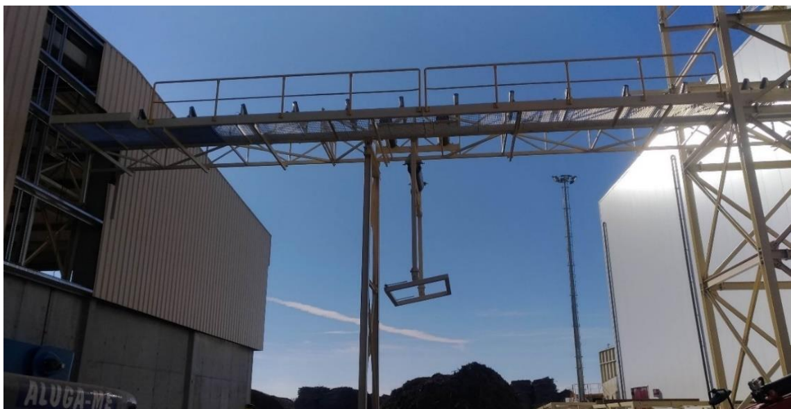
Figura 82 - Montagem de transportador no exterior do armazém
