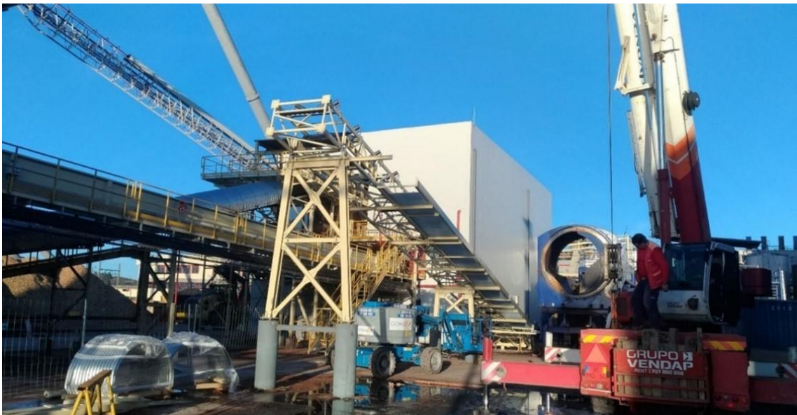
Figura 86 - Montagem do transportador inclinado.
