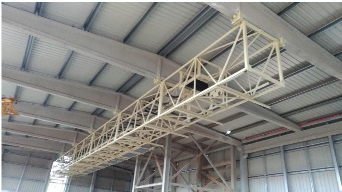
Figura 84 - Processo de instalação de transportadores no interior do armazém.
