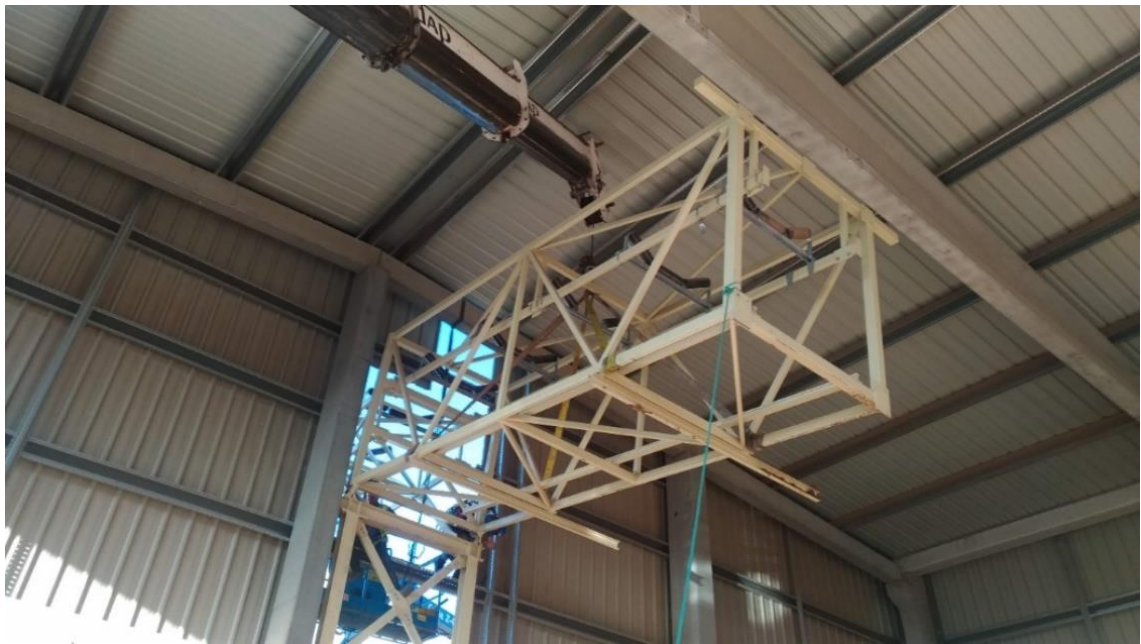
Figura 83 - Montagem do 1º Módulo no interior do armazém
