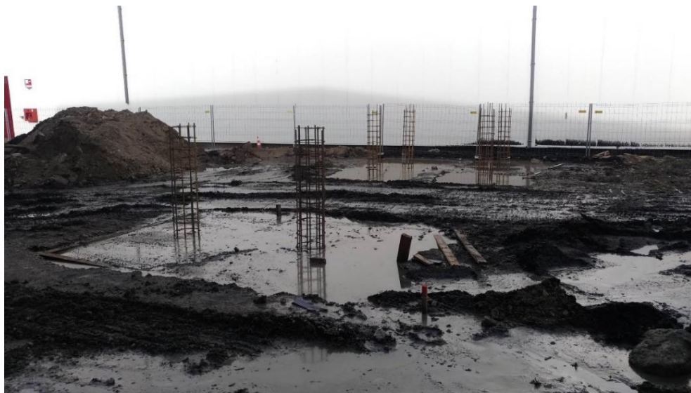
Figura 79 - Construção de sapatas de fundação para os transportadores
