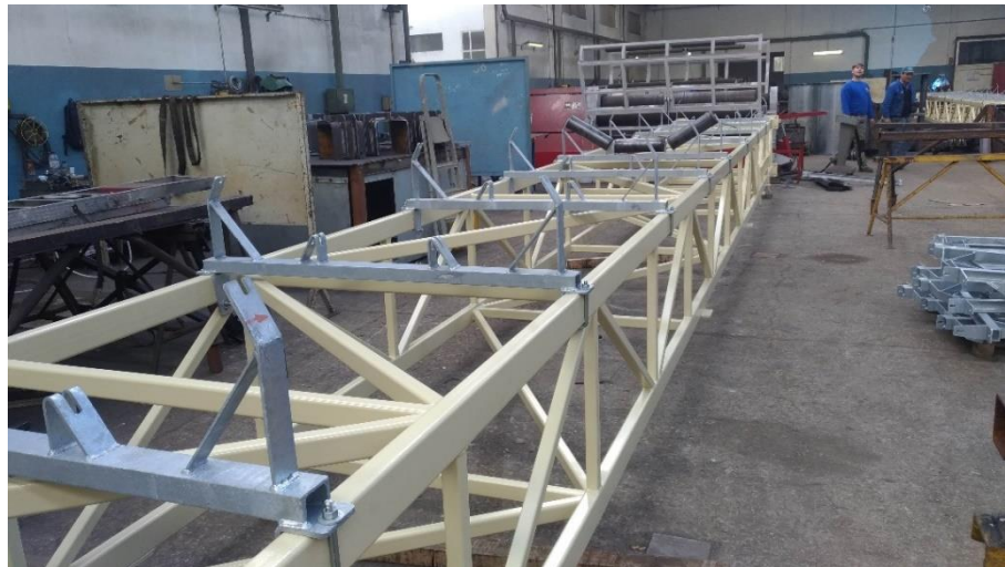
Figura 78 - Módulo do transportador inclinado em fase de finalização.
