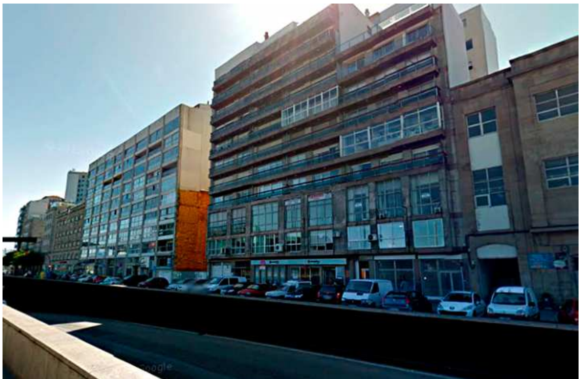
Fig. 4.5.1.8. Barrera física producida en el frente marítimo del Casco Vello por las edificaciones incoherentes construidas entre 1960 y 1990 vistas desde la unión entre la calle Montero Ríos y la avenida Beiramar.
