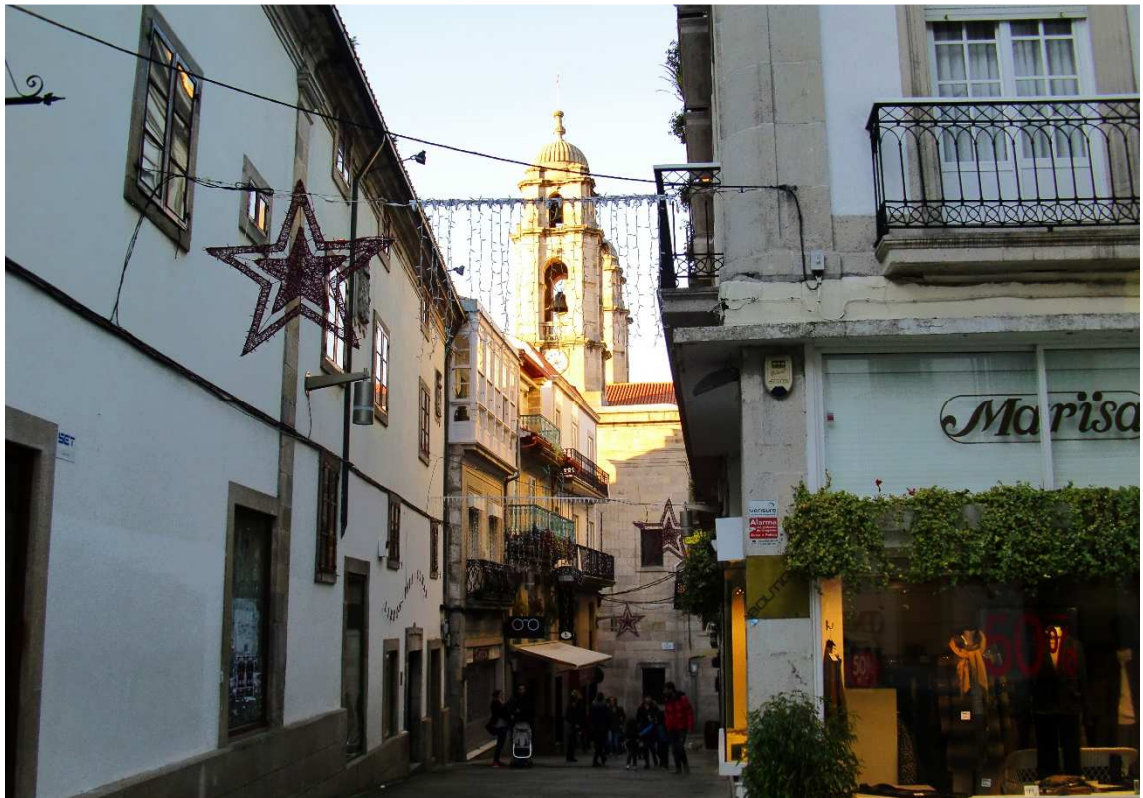
Fig. 4.5.1.31. Calle Triunfo. A la izquierda se observa un ejemplo de rehabilitación de fachada realizado durante el programa URBAN.
