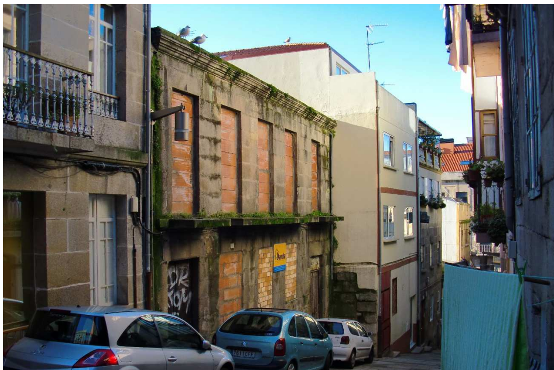
Fig. 4.5.1.10. Zona oeste del interior del Casco Vello. Se observa un edificio en elevado estado de degradación y abandono (Rent-gap) junto a una edificación incoherente construida entre 1960 y 1990.
