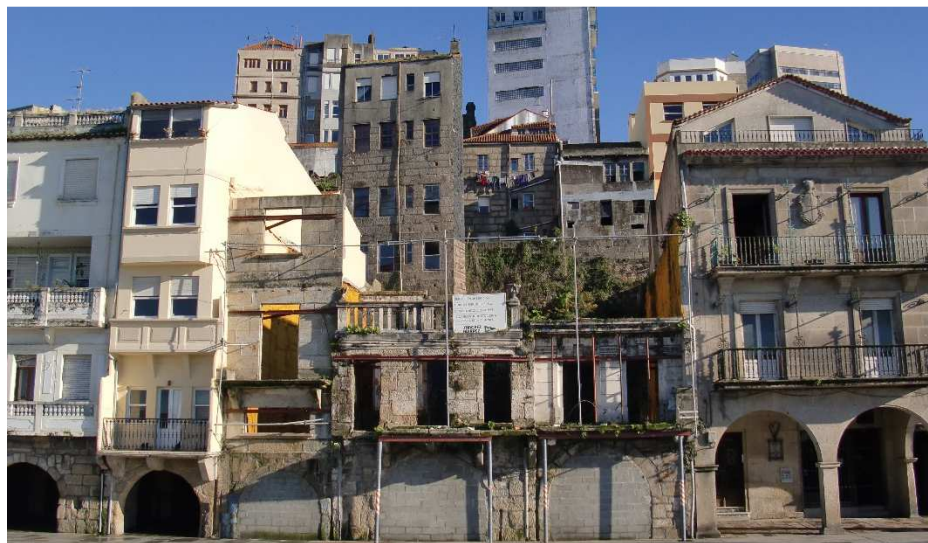
Fig. 3.4.21. Frente marítimo del Berbés. Espacio planteado para la próxima intervención del Consorcio.
