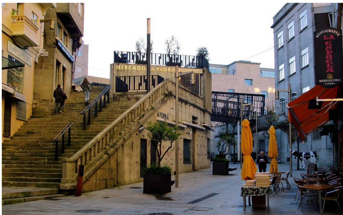
Fig. 4.5.1.26. Mercado de A Pedra, espacio rehabilitado por el programa URBAN.
