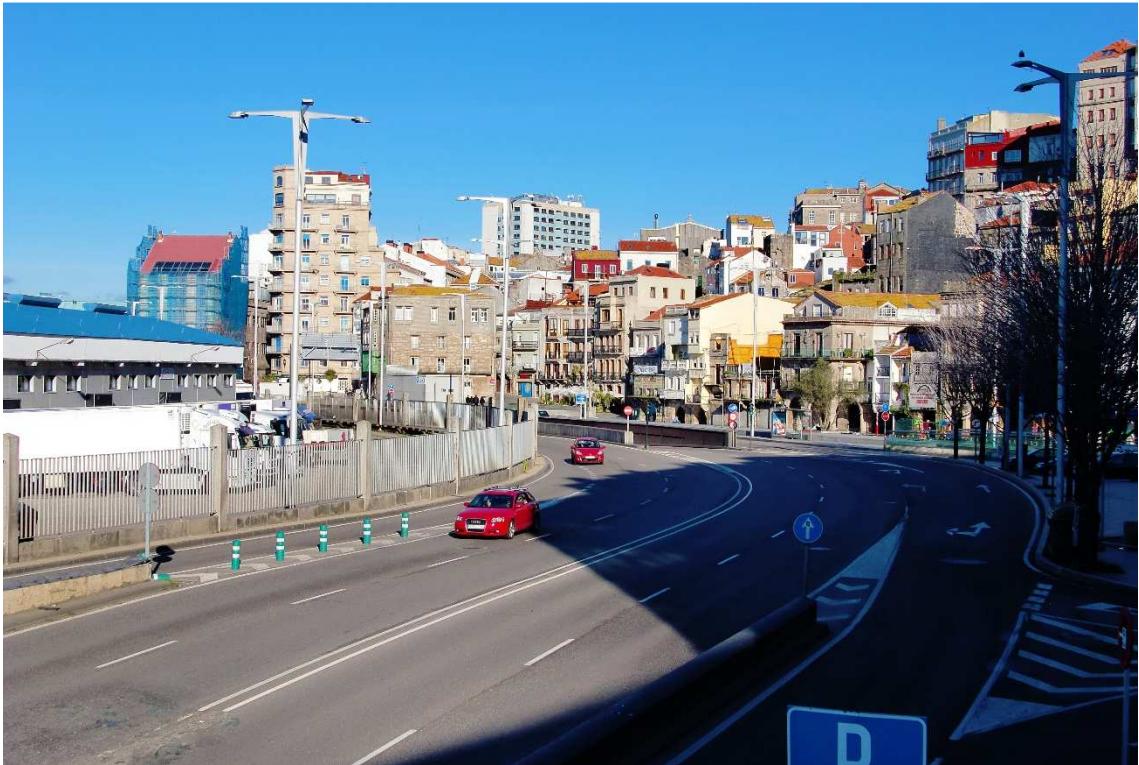
Fig. 4.5.1.19. Túnel subterráneo realizado por el programa Abrir Vigo al Mar. Se observa en la fotografía como las vías de circulación y las el puerto pesquero generan una barrera física que anula el contacto de la ribera del Berbés con el mar.
