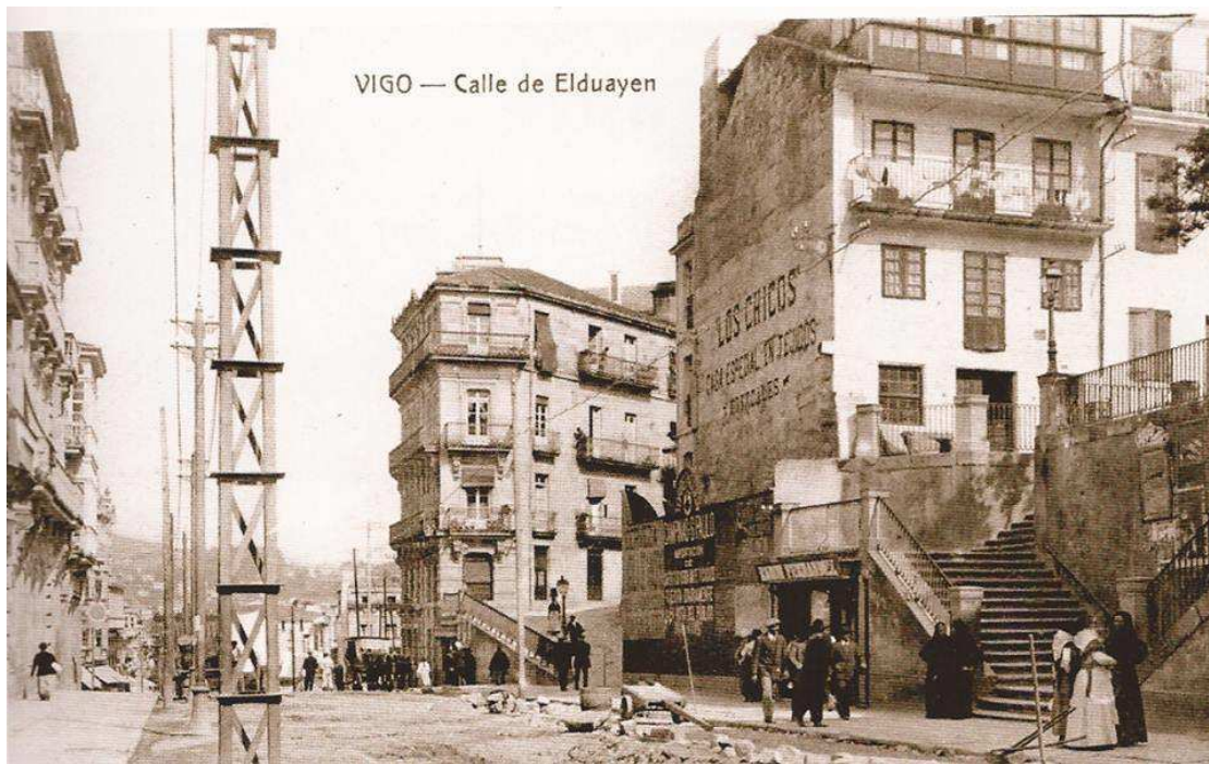
Fig. 4.3.1.14. Calle Elduayen todavía en construcción. Apertura de nueva vía que divide en dos la antigua ciudad intramuros.
