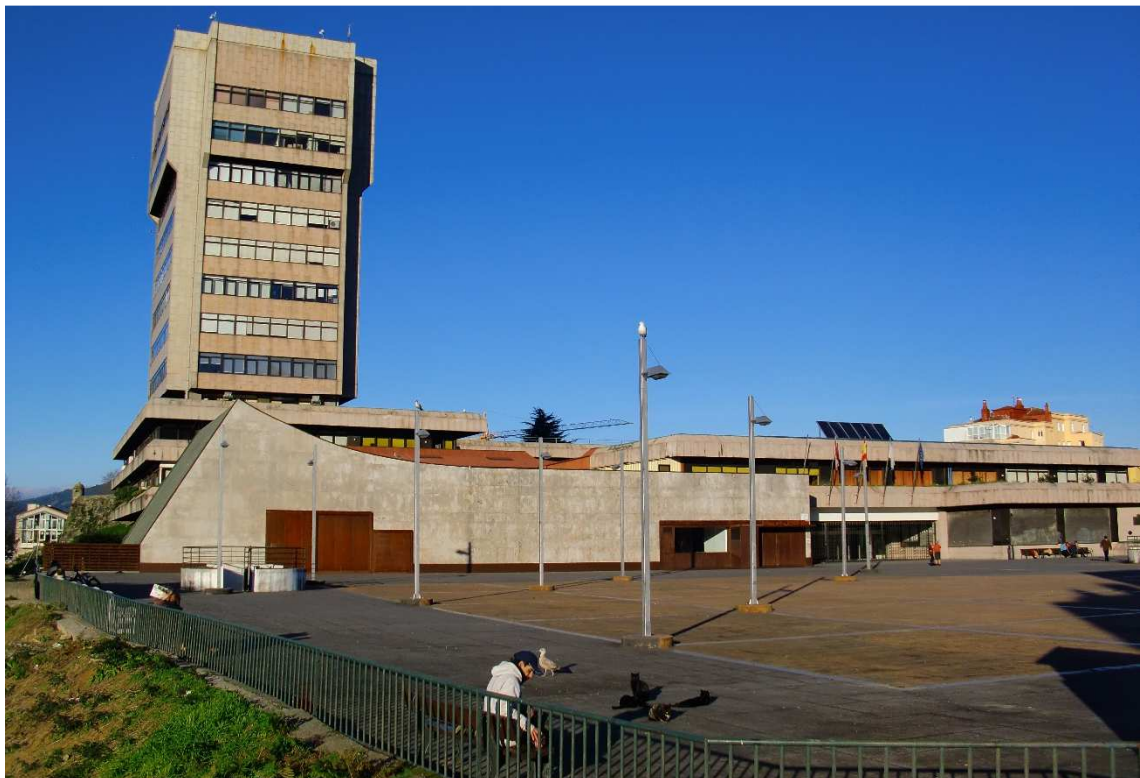
Fig. 4.5.1.16. Ayuntamiento de Vigo visto desde la plaza del Rey. Parte alta del Casco Vello. Construido en la década de 1970.
