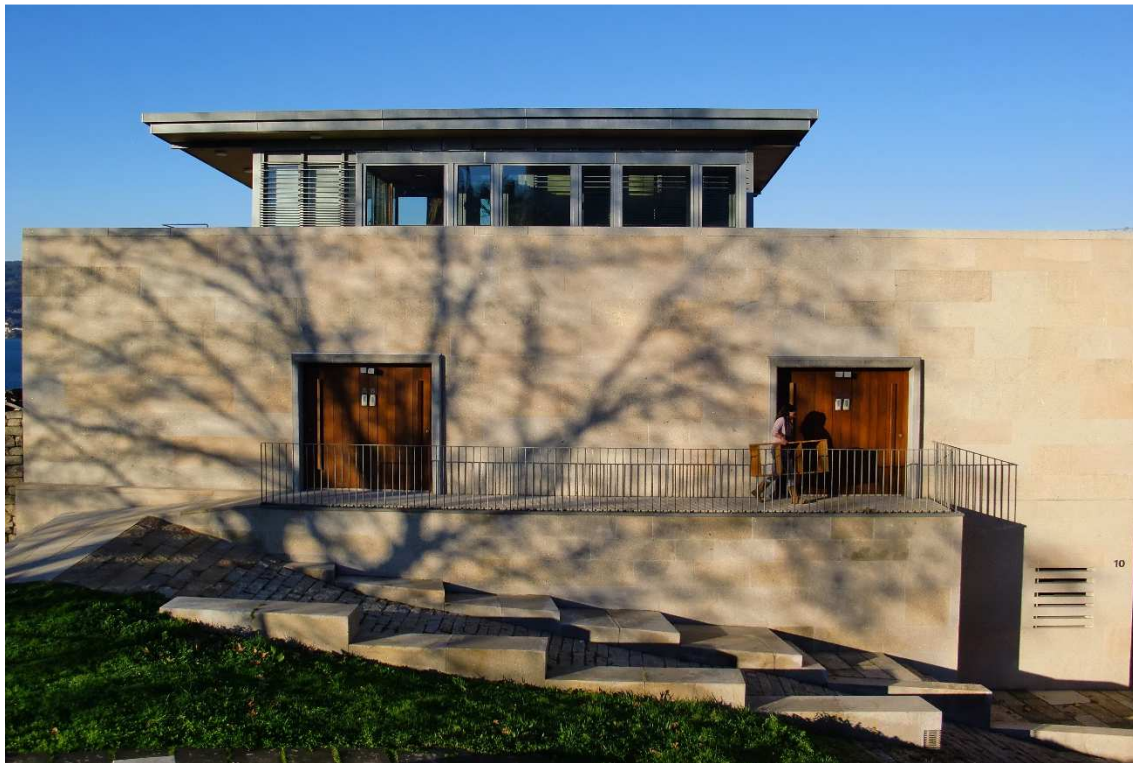
Fig. 4.5.1.37. Edificio residencial construido en la zona alta del Casco Vello por el Consorcio del Casco Vello.
