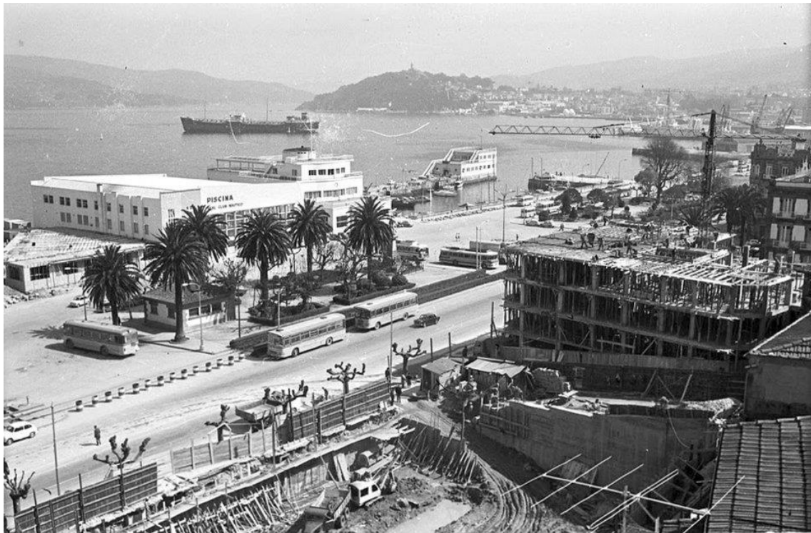
Fig. 4.4.1.23. Construcción de los nuevos edificios proyectados para el frente marítimo del Casco Vello durante la década de 1960.
