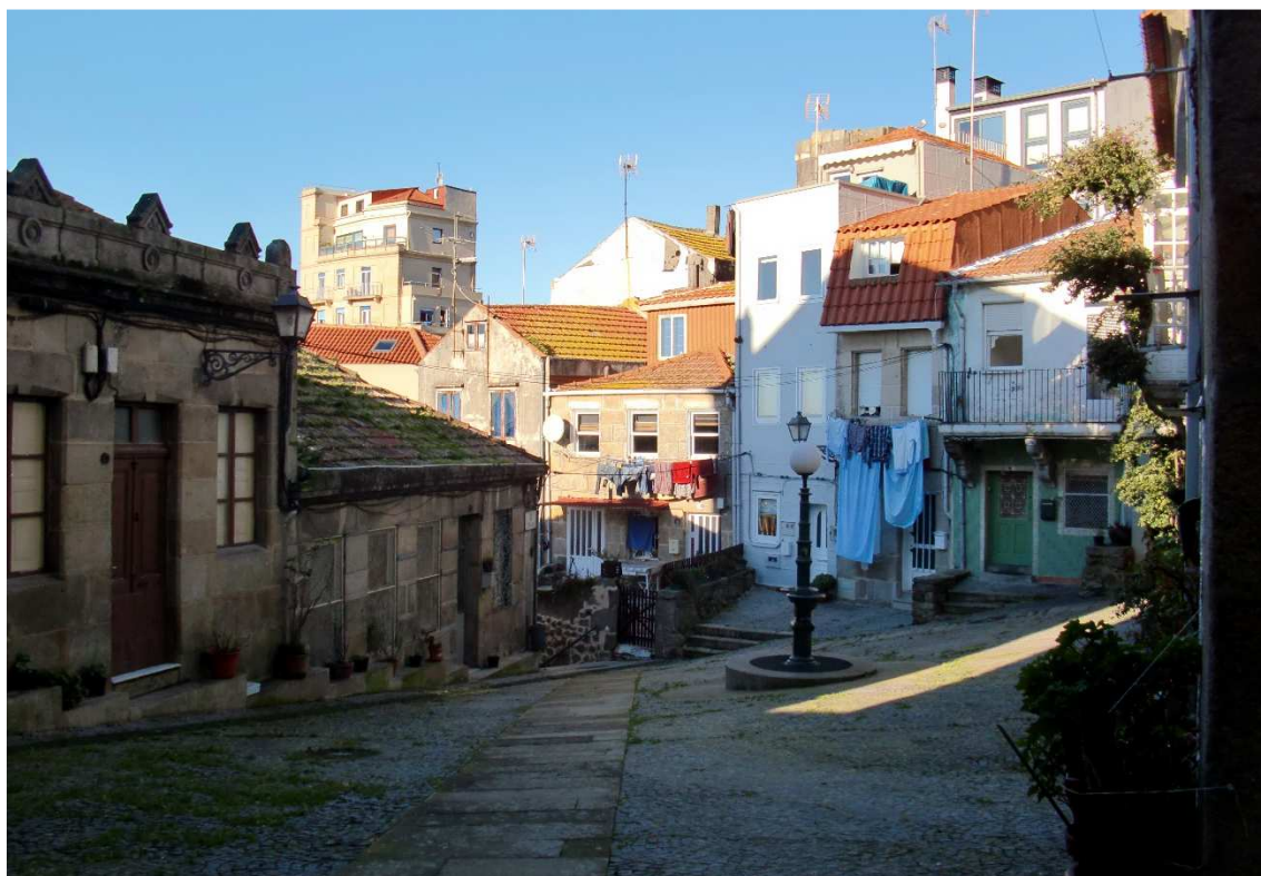
Fig. 4.5.1.29. Cruce entre las calles Poboadores, Anguía y Perigos, zona interior oeste del Casco Vello. Rehabilitación de pavimento y algunas fachadas durante el programa URBAN.
