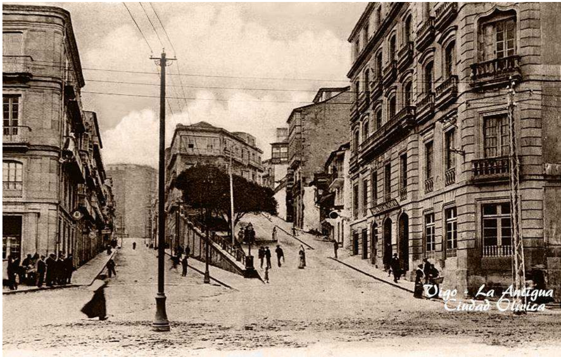
Fig. 4.3.1.16. Vista de la calle Carral tras el derribo de las murallas. Inicios siglo XX.
