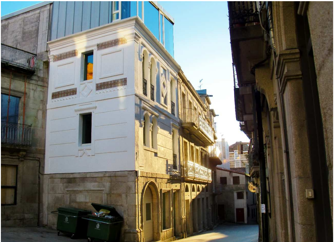
Fig. 4.5.1.43. Rehabilitación de edificio para uso administrativo (registros de la propiedad y mercantil) realizada por el Consorcio del Casco Vello en la calle Real.
