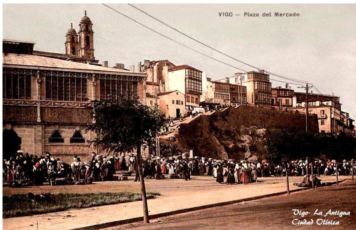
Fig. 4.3.1.7. Fotografía del Casco Vello desde el relleno de enlace con el Berbés. A la izquierda se observa el edificio del mercado de A Laxe. Principios de siglo XX.
