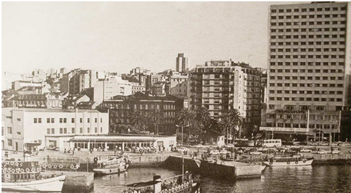
Fig. 3.4.15. Construcciones en el frente marítimo del Casco Vello en la década de 1960 derivadas de las ordenanzas de 1956 y la potenciación de la industria turística.
