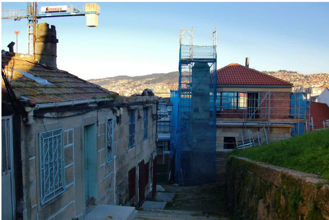
Fig. 4.5.1.38. Proceso de rehabilitación y revitalización de la zona alta del Casco Vello. Consorcio del Casco Vello.
