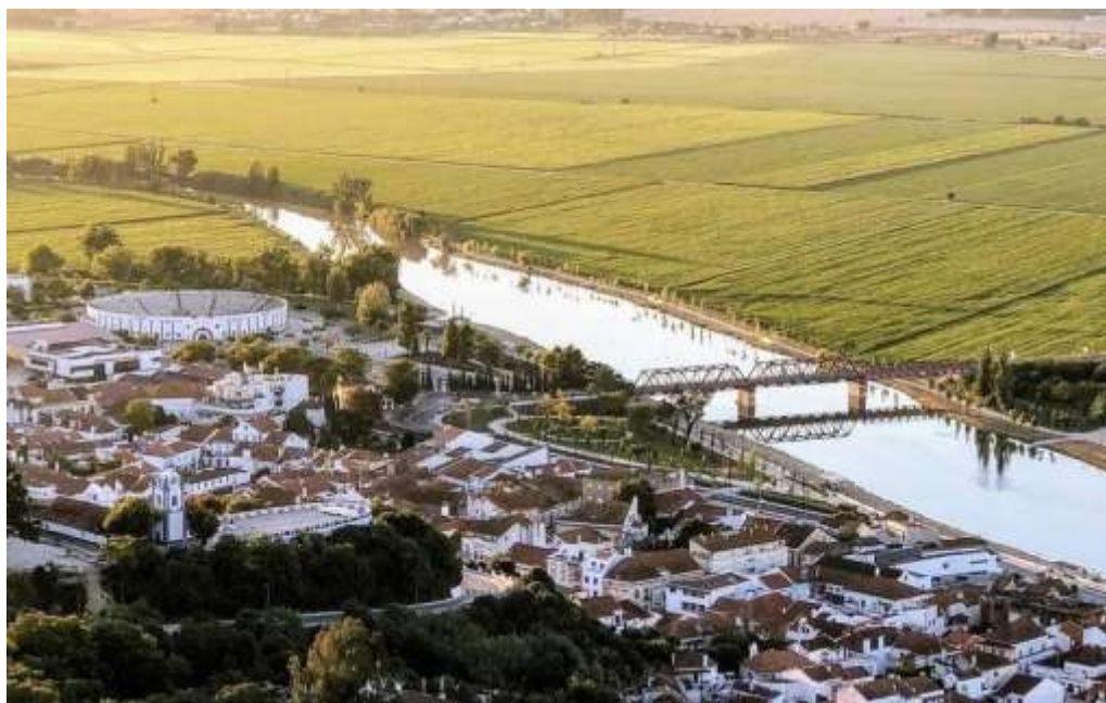
Figura 2 – Vila de Coruche, o Rio Sorraia e as pontes metálicas
