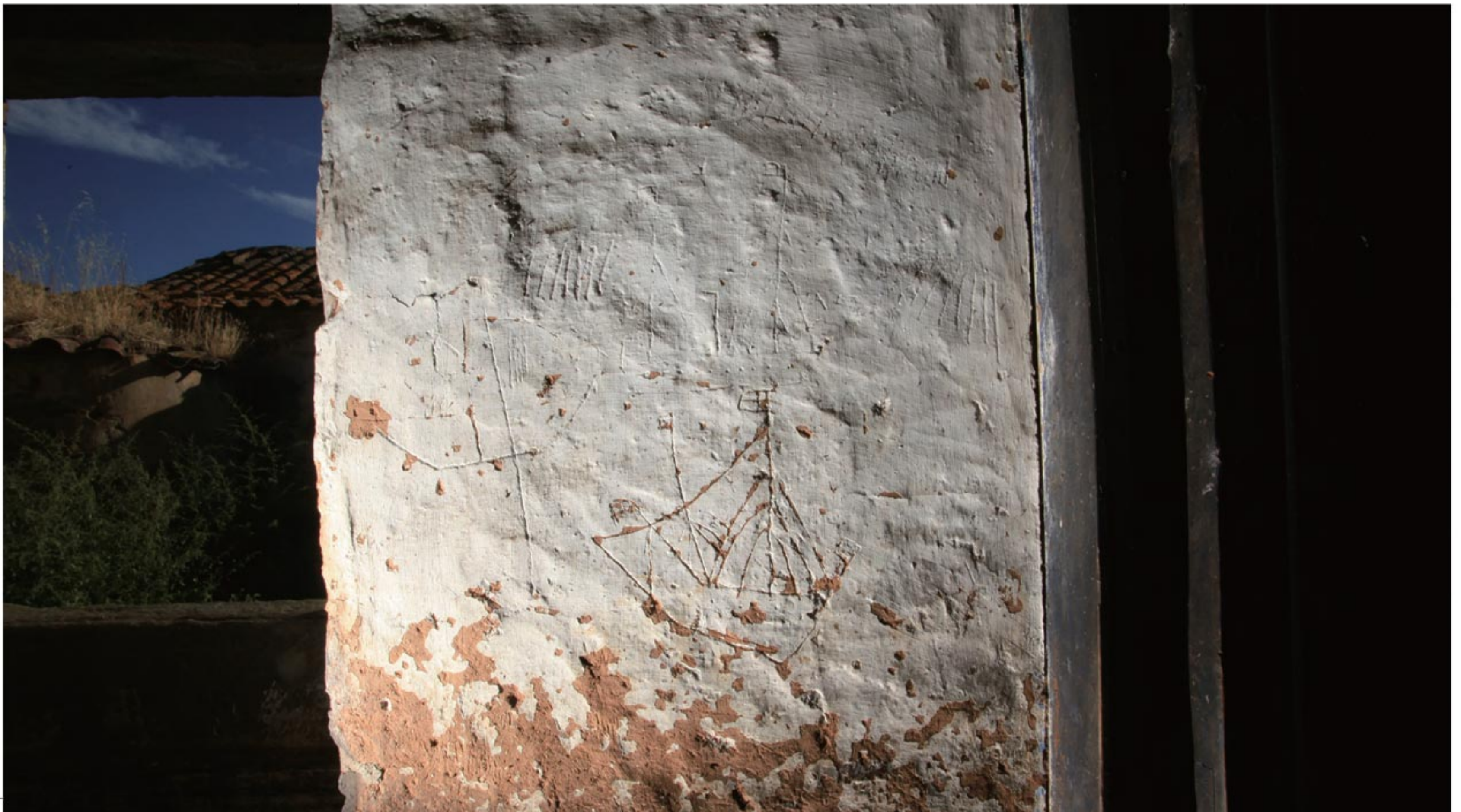
Figura 6. Representações de barcos numa das paredes internas da casa da Quinta da Barca (fotografia de Mário Reis).
