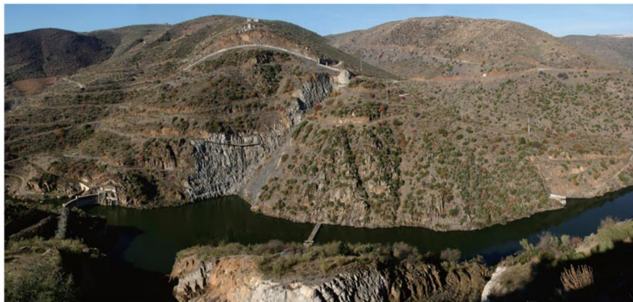
사진 1. 영원히 풍경에 간직될 거대한 코아 댐의 건설 속 유적.
