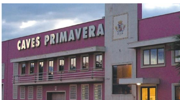
Figura 1- Vista da fachada principal das Caves Primavera.
