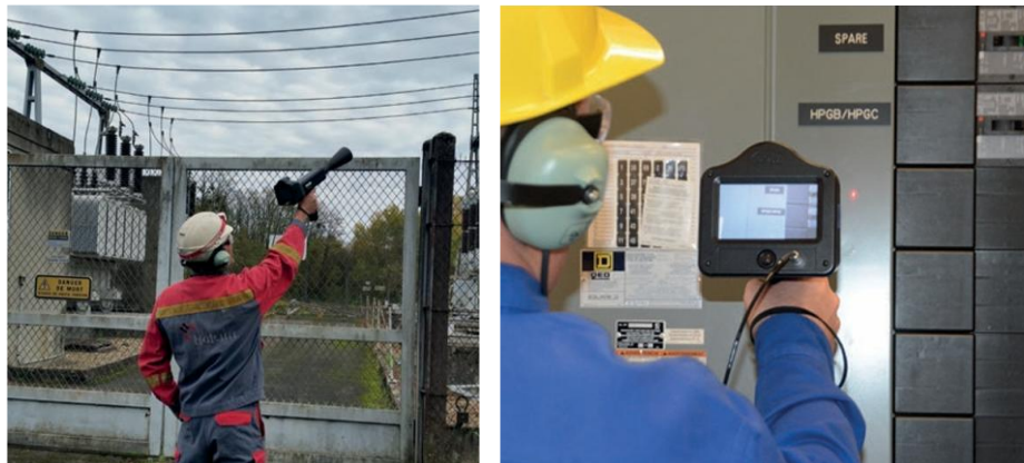
Figura 2.11 – Inspeção por ultrassons
