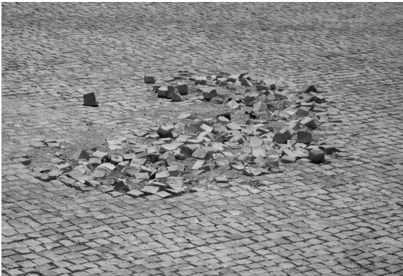
Figura 37 | Pavimento degradado
