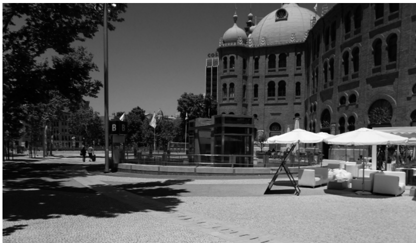
Figura 13 | A restauração na ocupação dos espaços exteriores. Praça de Touros do Campo Pequeno
