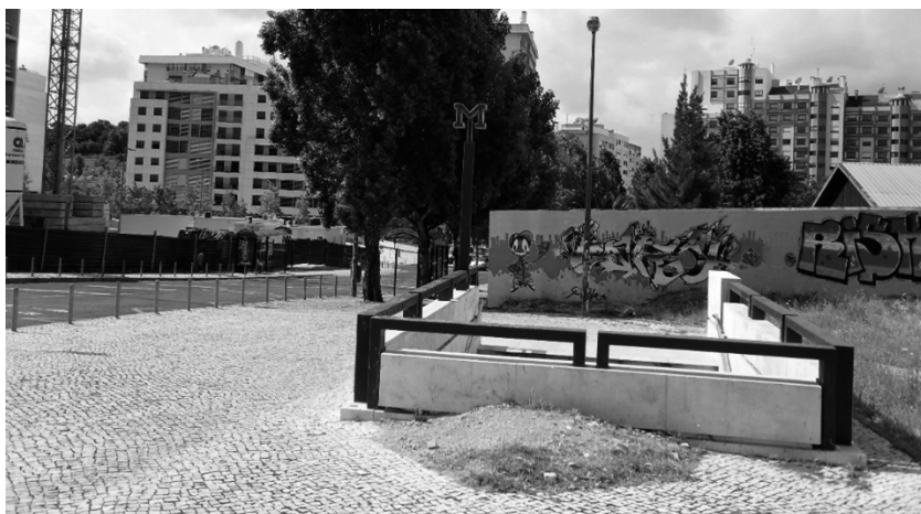
Figura 15 | Entrada da estação de metro. Alto dos Moinhos, Lisboa
