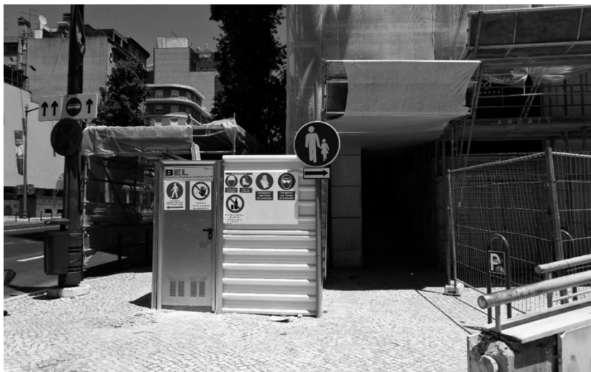
Figura 17 | Via pública ocupada por andaimes e tapumes. Saldanha, Lisboa
