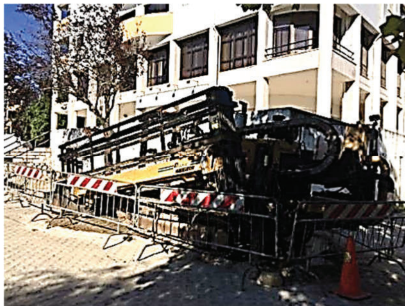
Foto n.º 40 - Máquina de perfuração dirigida (Perfurações Dirigidas do Centro, 2020)
