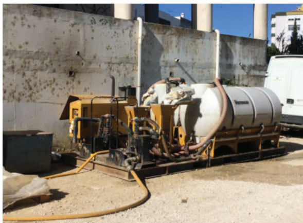
Foto n.º 1 - Central de mistura de lamas bentoníticas (Perfurações Dirigidas do Centro, 2020)
