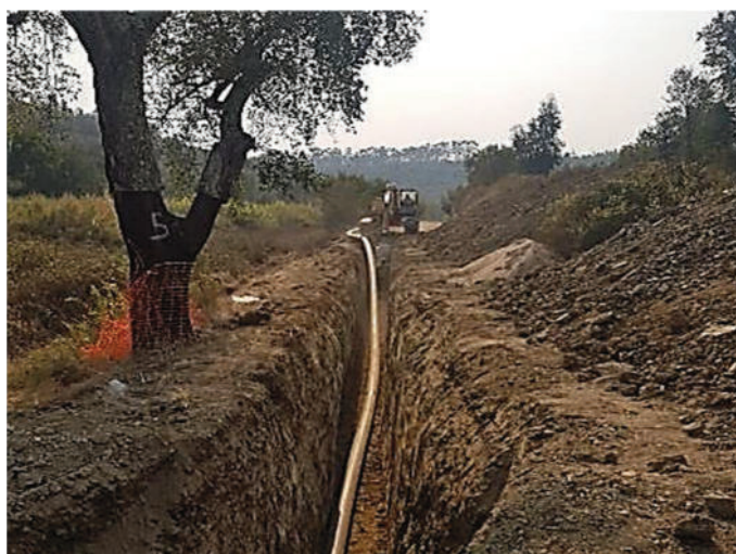
Foto n.º 3 - Exemplo de trabalhos com recurso a vala aberta
