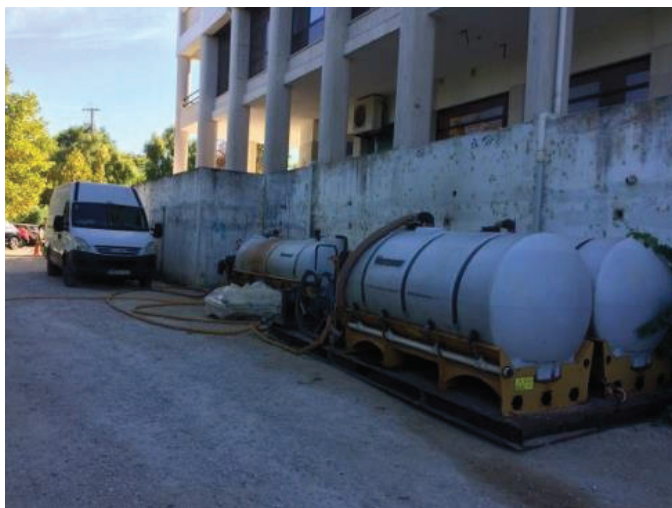
Foto n.º 39 - Central de mistura de lamas bentoníticas (Perfurações Dirigidas do Centro, 2020)
