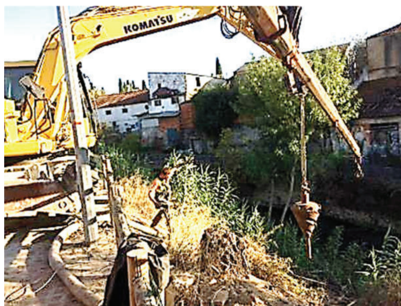
Foto n.º 41 - Giratória a posicionar broca expansora (vulgo Alargador)
