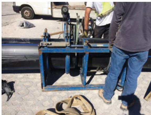
Foto n.º 46 - Demonstração de soldadura por termo fusão
