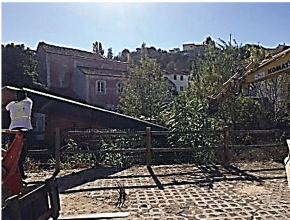
Foto n.º 44 - Finalização da colocação de Coletor PEAD diâmetro 500 sobre o rio
