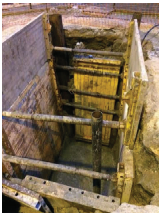
Foto n.º 59 - Escavação para execução de caixa de visita com soleira abaixo do nível freático (Aprox. 8m 2 )
