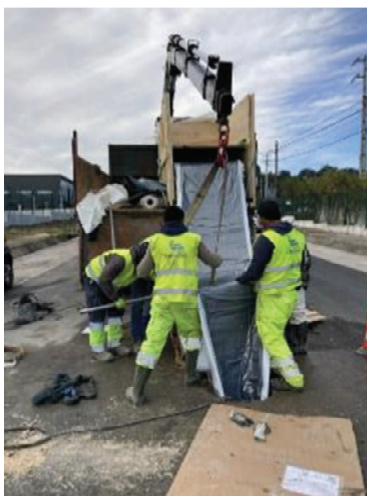
Foto n.º 17 - Início da introdução da manga pelo interior do coletor existente (Perfurações Dirigidas do Centro, 2020)
