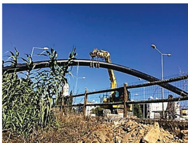
Foto n.º 51 - Apoio mecânico ao posicionamento do coletor
