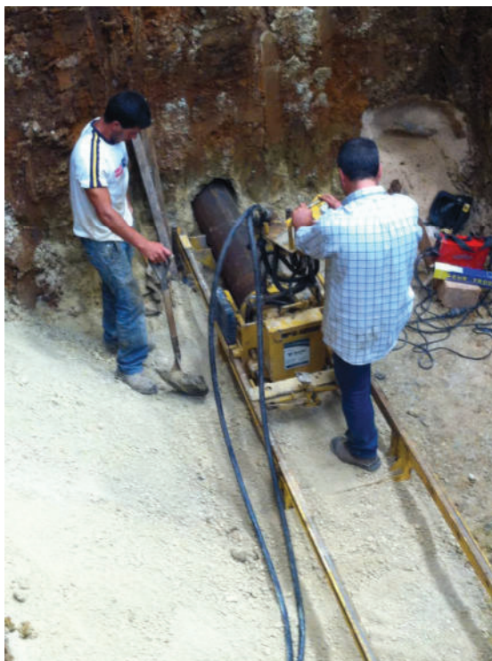
Foto n.º 62 - Perfuração por trados do último troço na ligação à estação elevatória
