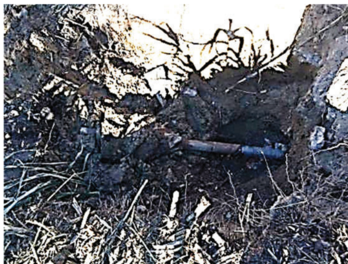
Foto n.º 43 - Pormenor de cabeça expansiva
