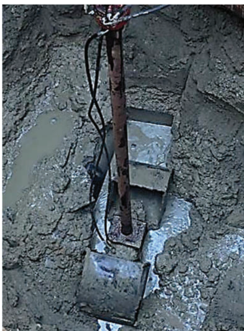
Foto n.º 61 - Pormenor do balde de patilhas
