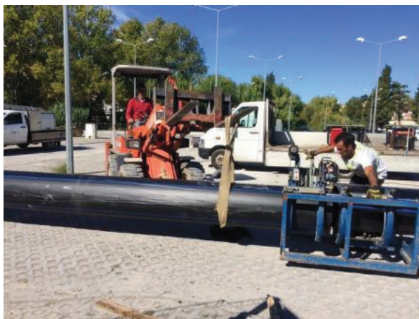
Foto n.º 49 - Apoio mecânico para posicionamento da tubagem para soldadura
