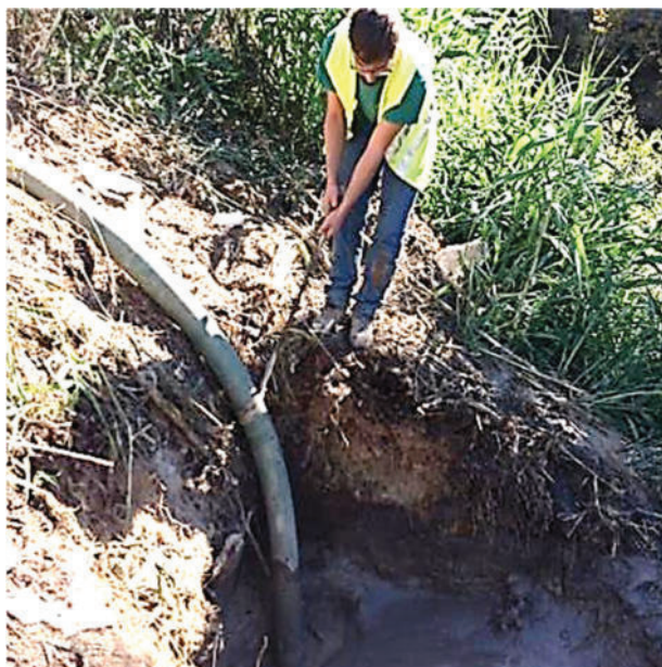
Foto n.º 42 - Sucção de lamas bentoníticas
