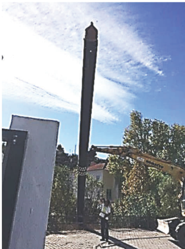
Foto n.º 52 - Apoio mecânico ao posicionamento do coletor
