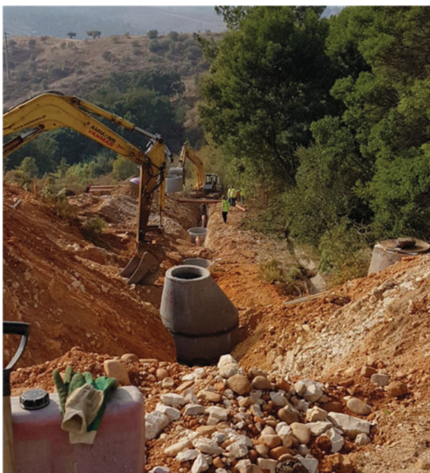
Foto n.º 28 - Colocação de Tubagem por vala aberta
