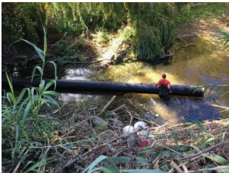
Foto n.º 54 - Apoio manual ao posicionamento do tubo sobre a água
