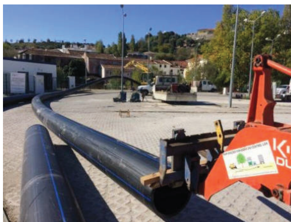
Foto n.º 47 - Apoio mecânico ao posicionamento do coletor
