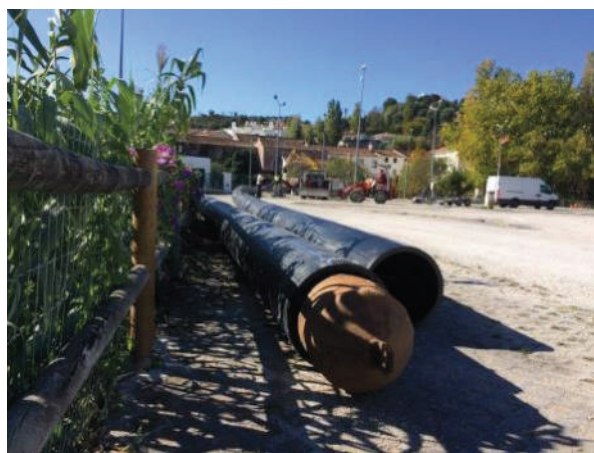
Foto n.º 50 - Cabeça de arraste fixa ao tubo PEAD
