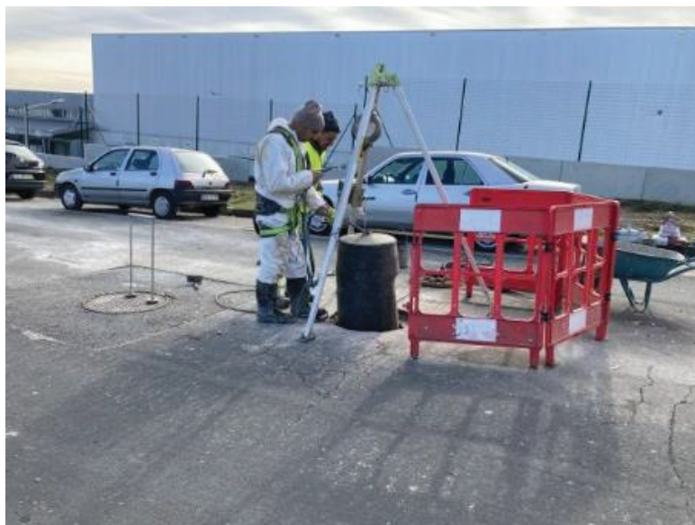
Foto n.º 26 - Balão de tamponamento do coletor a montante da intervenção (Perfurações Dirigidas do Centro, 2020)
