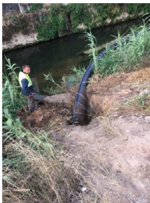
Foto n.º 57 - Início á introdução do coletor no furo já efetuado
