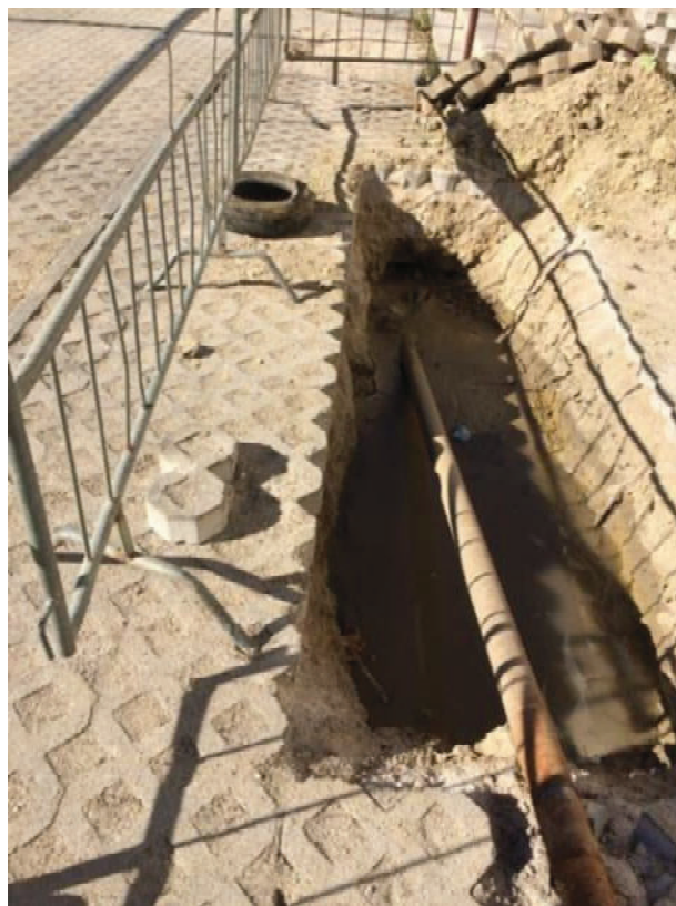
Foto n.º 38 - Poço de ataque, início da perfuração (Perfurações Dirigidas do Centro, 2020)
