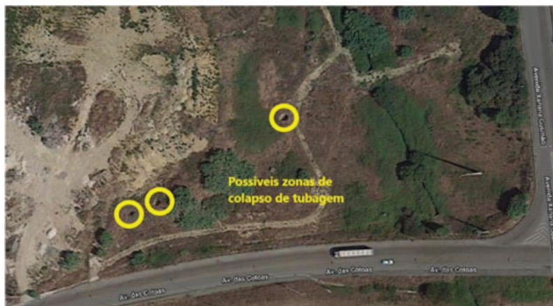
Foto n.º 15 - Crateras visíveis coincidentes com o traçado da tubagem – podem ser zonas de colapso / cedência da tubagem.
