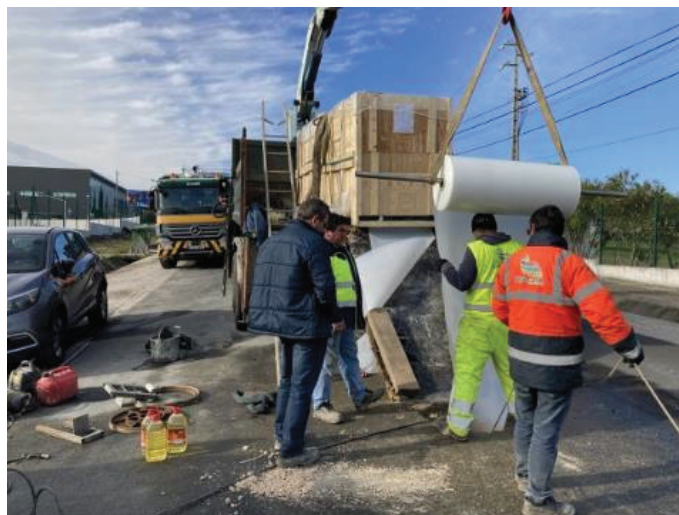
Foto n.º 16 - Introdução de manga plástica para diminuir atrito ao colocar a manga no interior do coletor existente (Perfurações Dirigidas do Centro, 2020)
