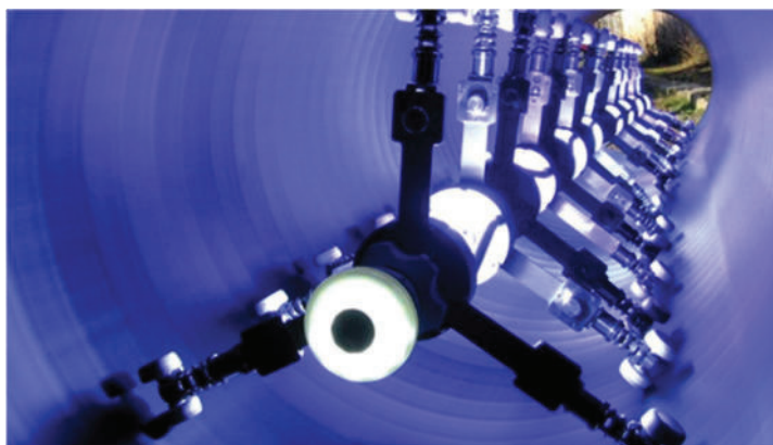
Figura n.º 10 - Cura da manga por lâmpadas Ultravioletas
