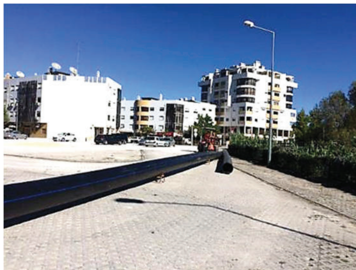
Foto n.º 53 - Giratória a empurrar tubo PEAD
