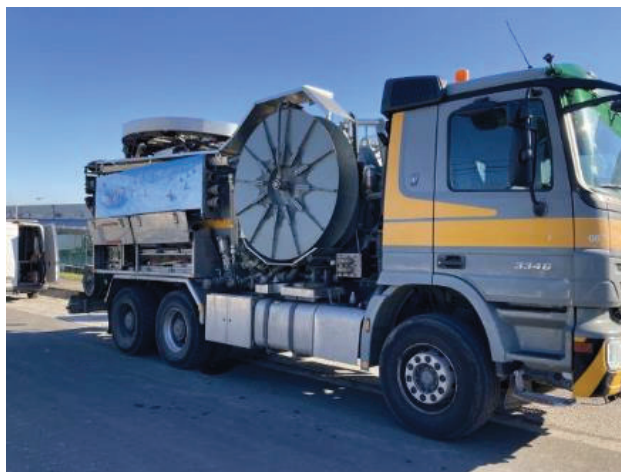
Foto n.º 18 - Camião Hidroaspirador para apoio na limpeza dos coletores (Perfurações Dirigidas do Centro, 2020)
