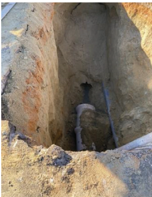
Foto n.º 27 - Reparação de coletor que se encontrava desfeito de forma a permitir a passagem da manga (Perfurações Dirigidas do Centro, 2020)
