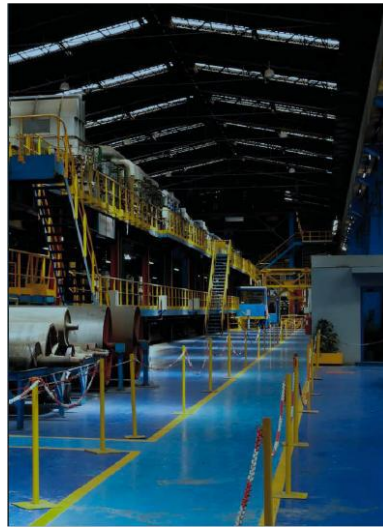
Figura 8 - Linha de Galvanização
