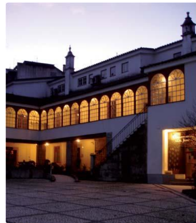
Figura 5: Edifício do Conservatório
