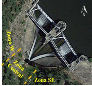
Figura 1 - Vista Aérea do Descarregador
