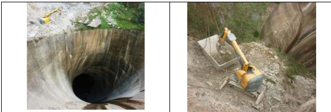
Figura 6 e 7 - Escavação com a Giratória Robotizada na base do talude (descarregador)
