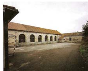
Fachadas traseras. Estados inicial y final
