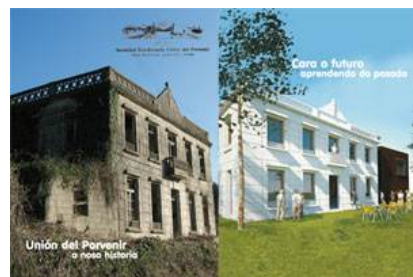
Fig. 13: Unión del Porvenir; El estado ruinoso en el que se encontraba llevo a la propuesta que se está realizando.
