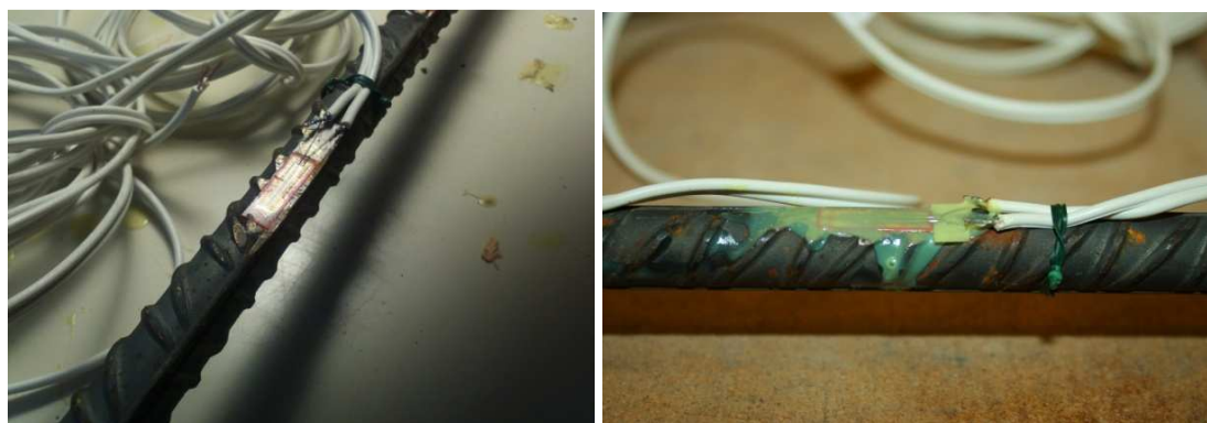
Figura 4.11 – Execução de ligações e colagem de protecção do extensómetro
