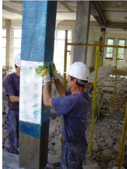
Figura 2.7 - Colagem de manta GFRP em pilar (Maranha, 2011).
