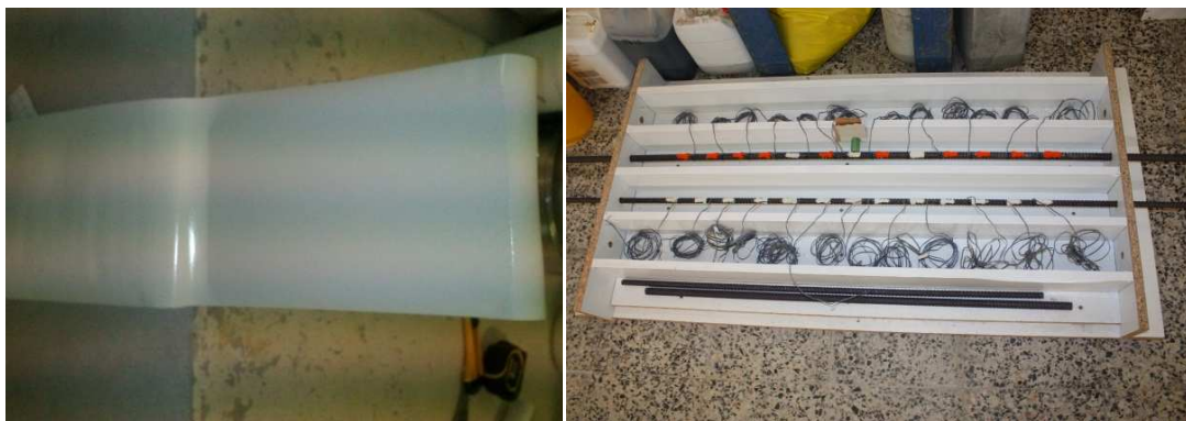
Figura 4.13 - Colagem de capa plástica e preparação da cofragem
