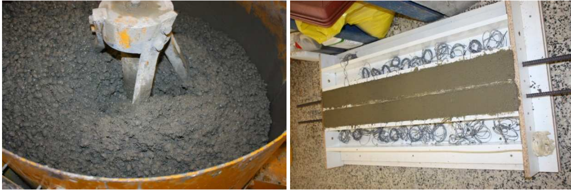
Figura 4.14 - Execução de amassadura e betonagem dos tirantes
