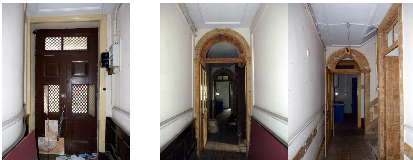
16 | Levantamento fotográfico da situação existente - Hall de entrada (Piso 0)
