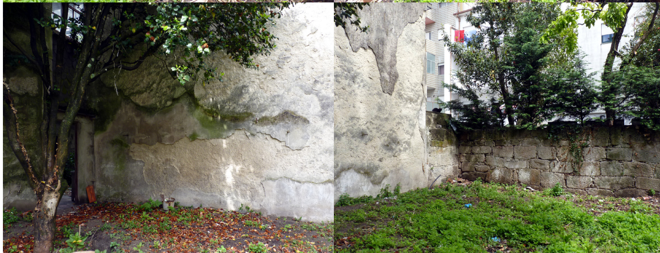
32 | Levantamento fotográfico da situação existente - Logradouro Nascente
