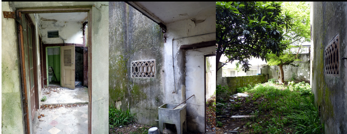
33 | Levantamento fotográfico da situação existente - Logradouro Norte
