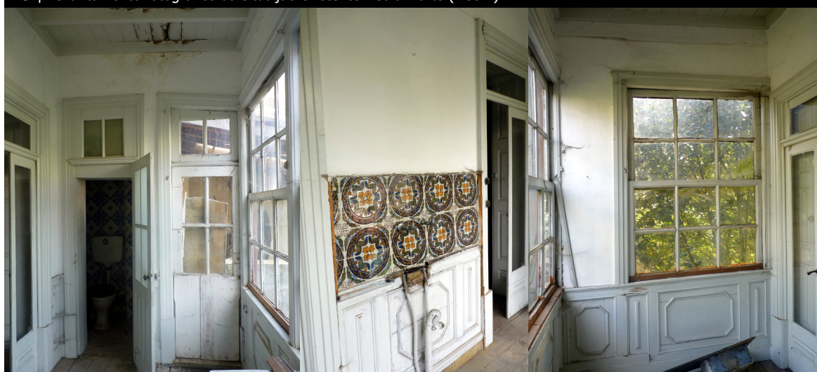
21 | Levantamento fotográfico da situação existente - Marquise e I. Sanitária (Piso 1)
