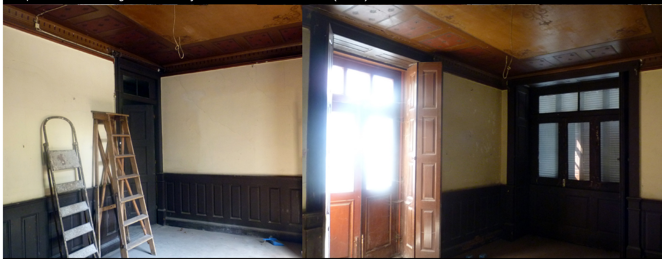
17 | Levantamento fotográfico da situação existente - Escritório (Piso 0)
