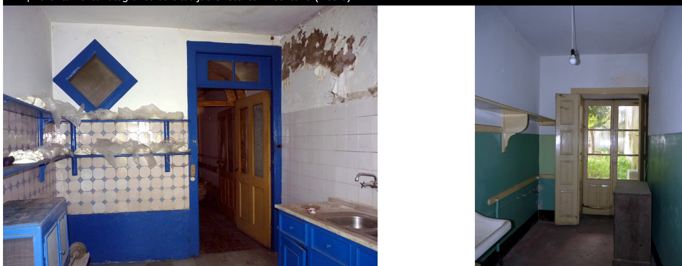
18 | Levantamento fotográfico da situação existente - Cozinha e I. Sanitária (Piso 0)
