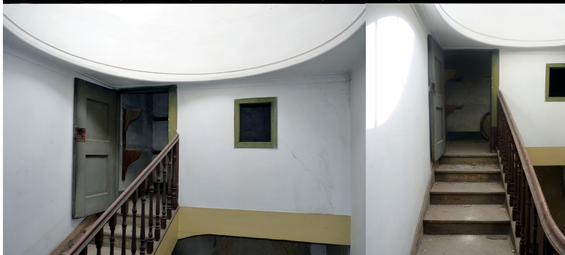
29 | Levantamento fotográfico da situação existente - Arrumo (Piso 4 - recuado)
