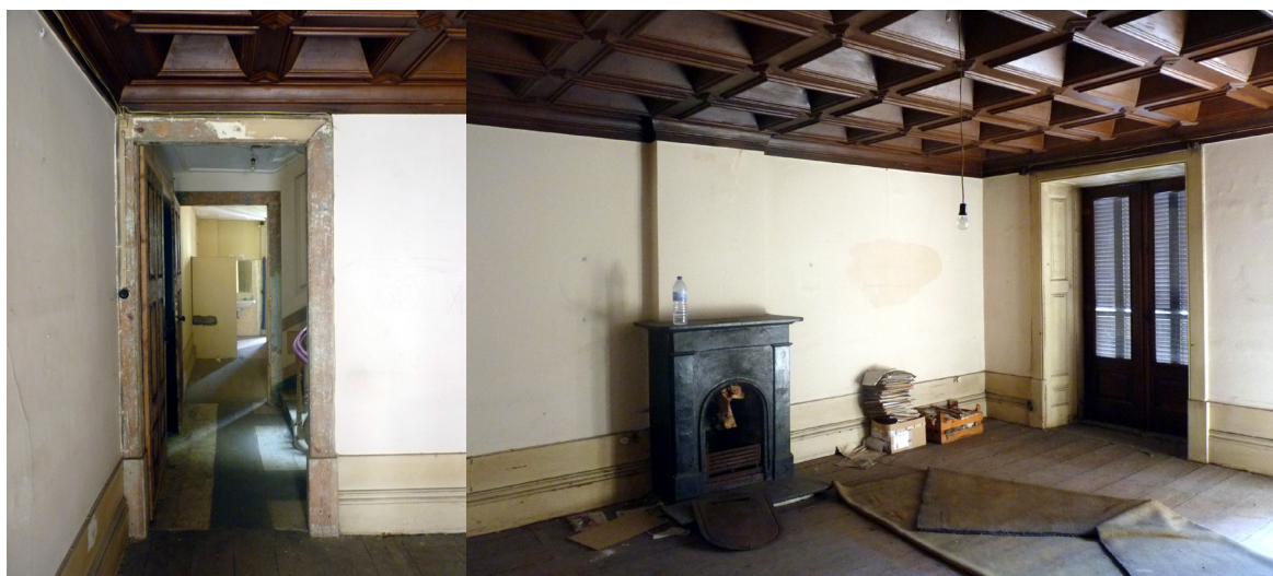
22 | Levantamento fotográfico da situação existente - Sala Sul (Piso 2)
