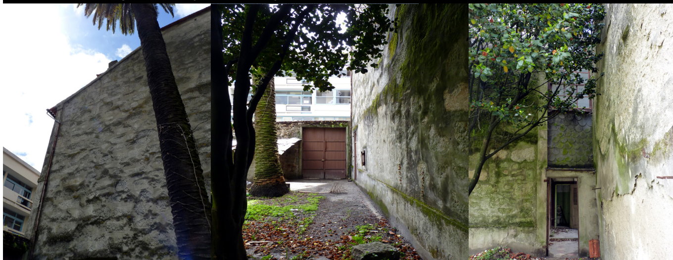
14 | Levantamento fotográfico da situação existente - Alçado Nascente
