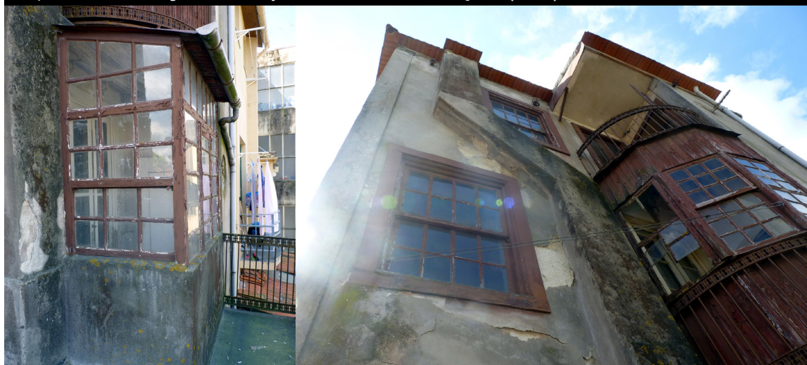
24 | Levantamento fotográfico da situação existente - Terraço (Piso 2)
