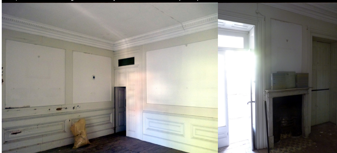
20 | Levantamento fotográfico da situação existente - Sala Norte (Piso 1)
