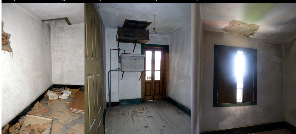
30 | Levantamento fotográfico da situação existente - Quartos a Norte (Piso 4 - recuado)
