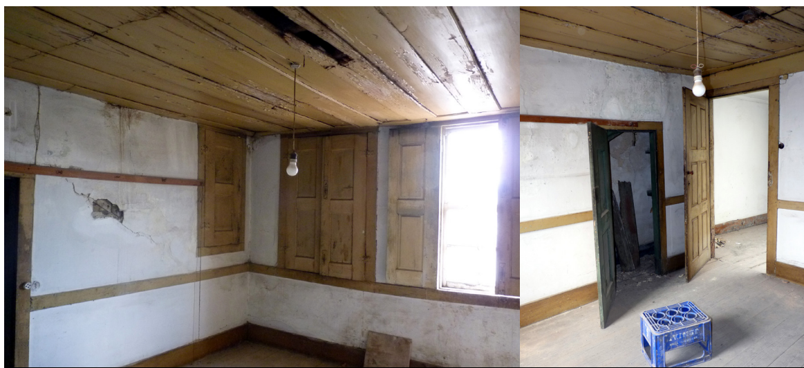
28 | Levantamento fotográfico da situação existente - Quarto a Sul (Piso 4 - recuado)
