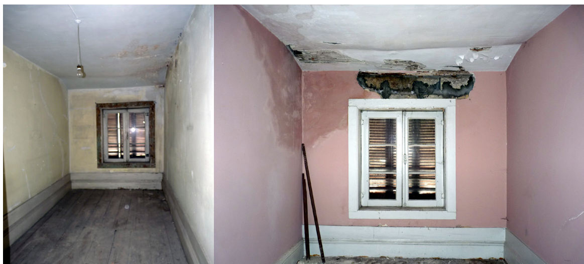
25 | Levantamento fotográfico da situação existente - Quartos a Sul (Piso 3)
