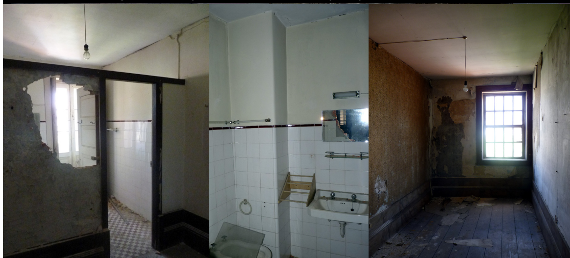
26 | Levantamento fotográfico da situação existente - I. Sanitária e Quartos a Norte (Piso 3)
