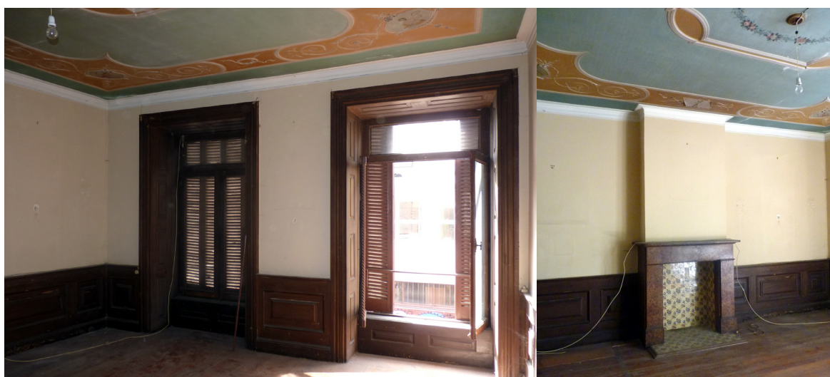
19 | Levantamento fotográfico da situação existente - Sala Sul (Piso 1)
