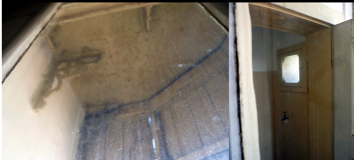
27 | Levantamento fotográfico da situação existente - Marquise e I. Sanitária (Piso 3)
