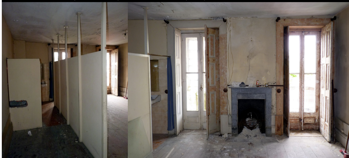
23 | Levantamento fotográfico da situação existente - I. Sanitária e Quarto (Piso 2)
