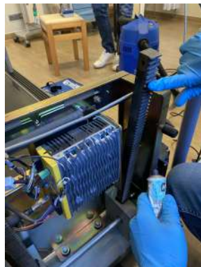
(c) Lubrificação de sistema de elevação
