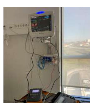
(d) Teste de segurança elétrica
