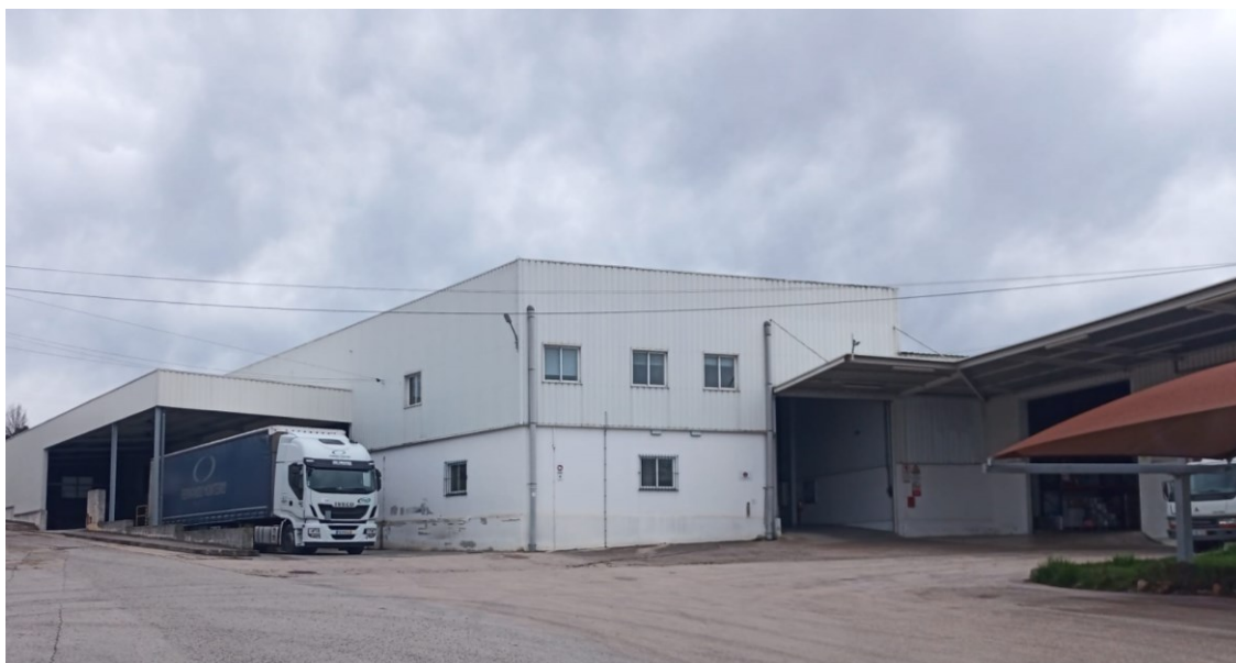
Figura 1.4 - Instalações da MOVIESTRADA
