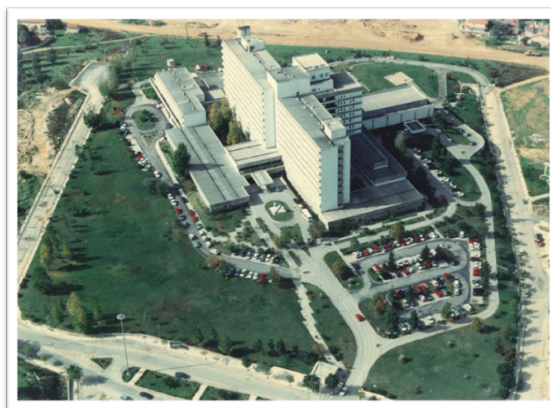
Figura 24 – Hospital Distrital de Santarém [40].
