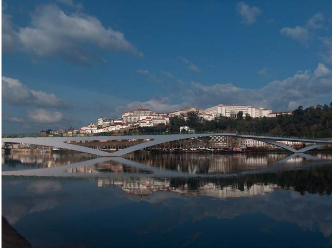
Figura 1. Ponte pedonal Pedro e Inês, Coimbra.
