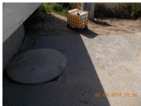
Fig. 10: Tanque de recolha de efluentes, na empresa Detalhe Campestre
