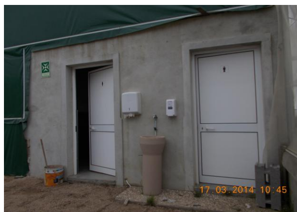
Fig. 6: Sanitários na empresa Detalhe Campestre
