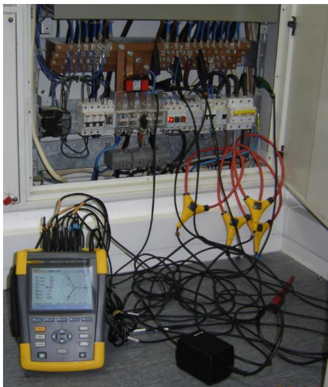
Figura 4.3. Imagem da ligação do analisador de rede Fluke
