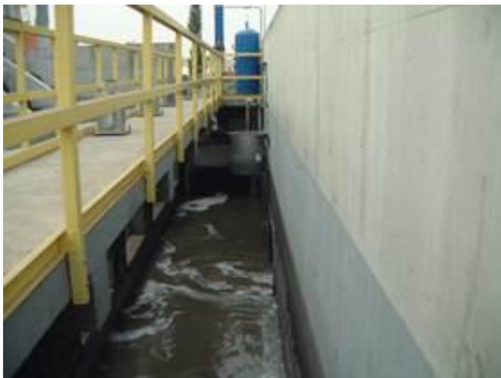
Figura 1 – Entrada do Efluente
