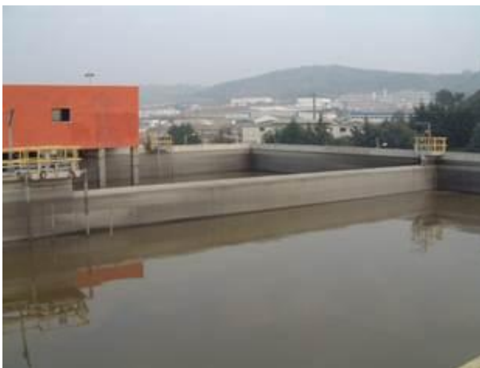
Figura 8 – Tanques de Equalização (2)
