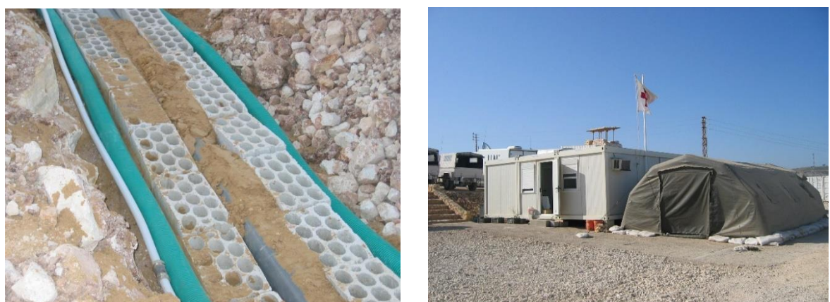
Figura 32 - Redes de abastecimento e saneamento (à esquerda) e edifício da enfermaria (à direita)
