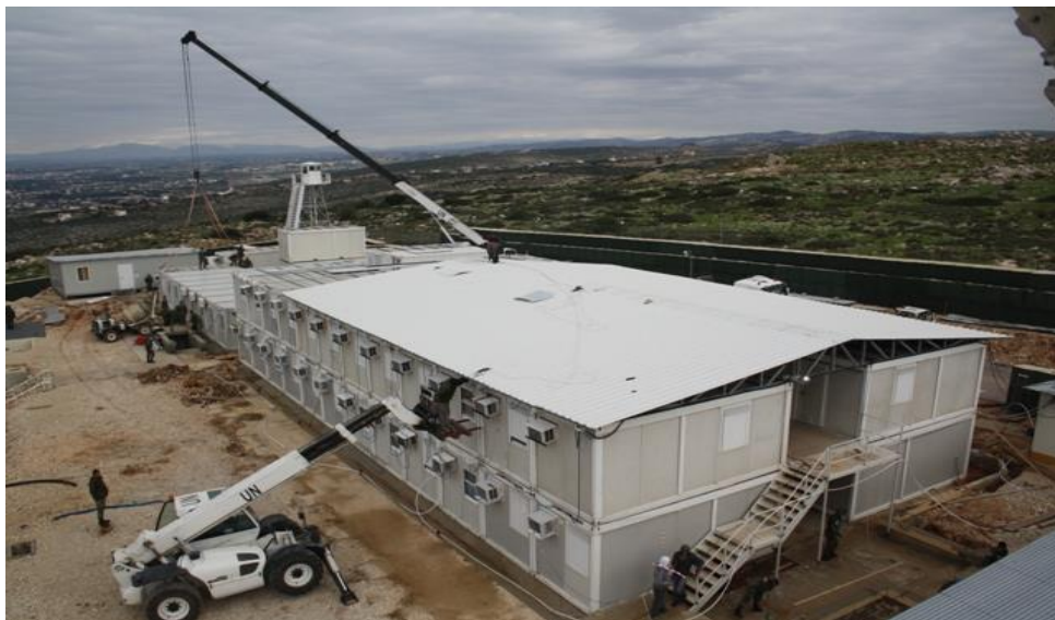
Figura 28 - Construção dos edifícios de alojamento
