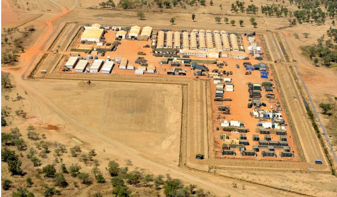
Figura 16 - Aquartelamento temporário, Chade
