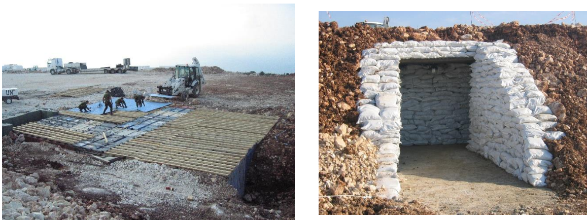
Figura 30 - Construção do bunker equipado com contentores
