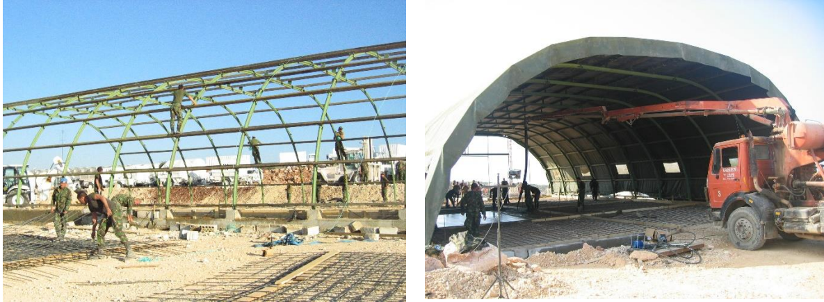
Figura 29 - Construção da tenda oficina
