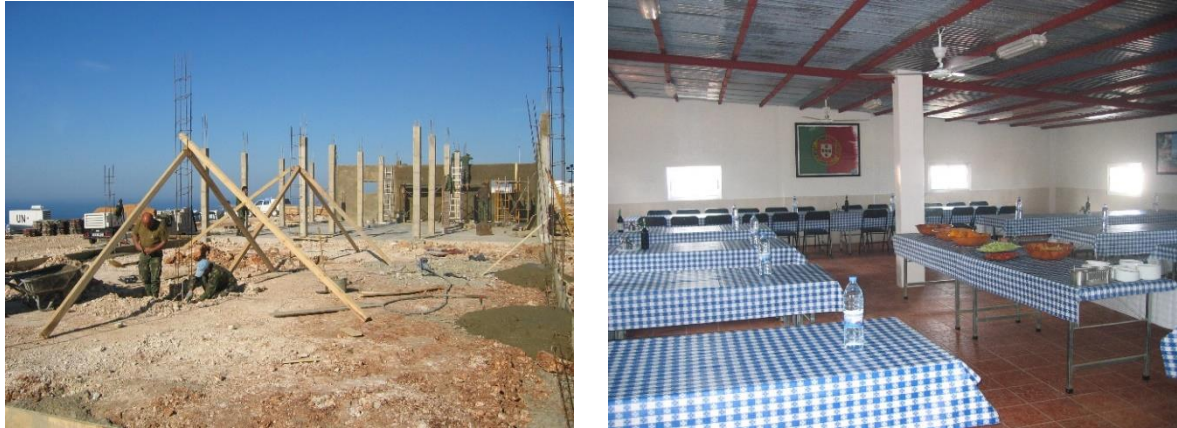
Figura 31 - Construção do refeitório
