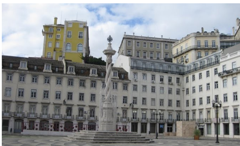
Figura 3.8. Edifício de habitação e comércio, na Praça do Município em Lisboa [PROSIRTEC, Arquivo da empresa]
