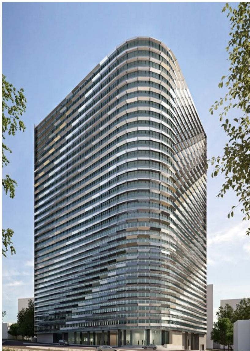
Figura 3.12. Edifício de habitação, escritórios e comércio Muxima em Luanda, Angola [PROSIRTEC, Arquivo da empresa]
