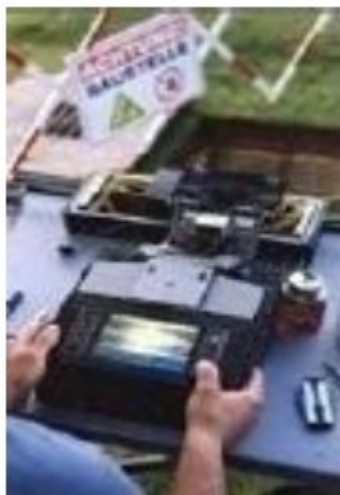
Figura 2.18. Exemplo de uma junta por fusão [ANACOM, MANUAL ITED,2009]
