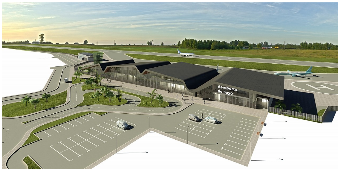
Figura 3.9. Aeroporto do Soyo em Angola [PROSIRTEC, Arquivo da empresa]
