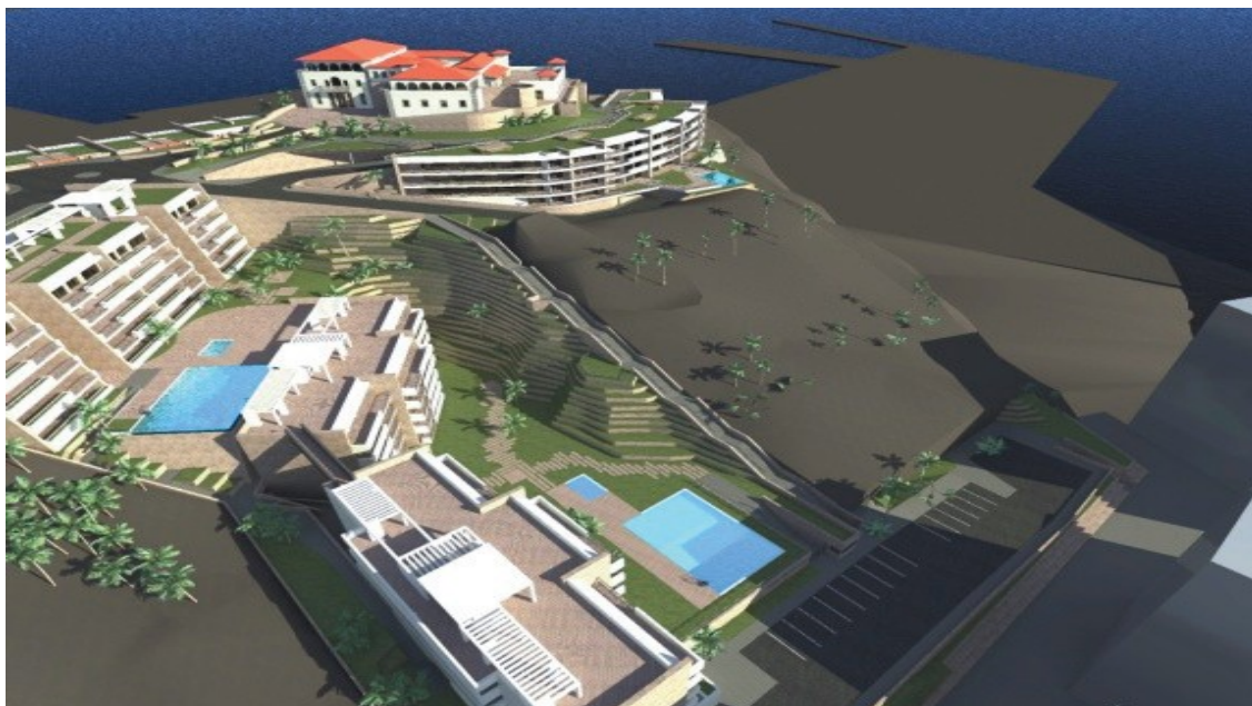
Figura 3.5. Fortim em Cabo Verde, plano picado [PROSIRTEC, Arquivo da empresa]
