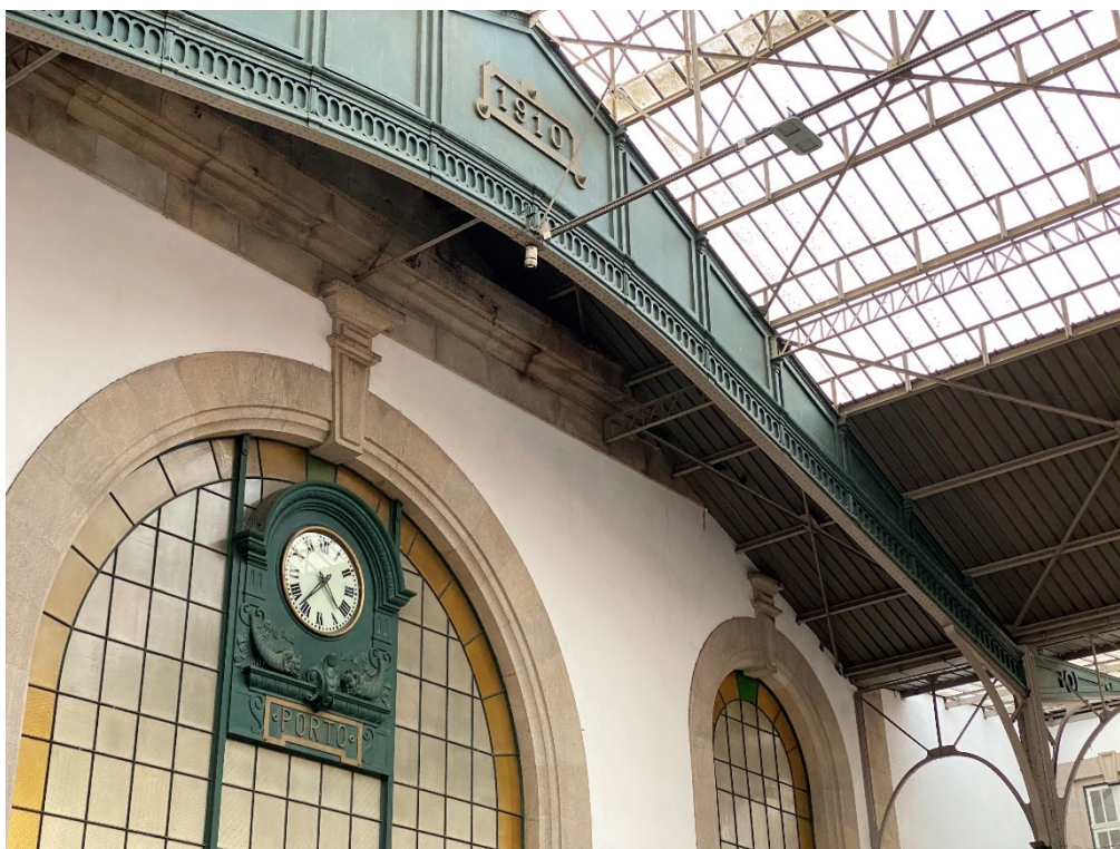
Fig. XIV Fotografia, a partir da plataforma, onde se observa a ligação entre a cobertura e o corpo principal do edifício
