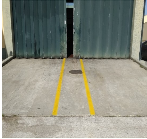
Figura 49 - Linhas de orientação no acesso à fossa de lavagem.
