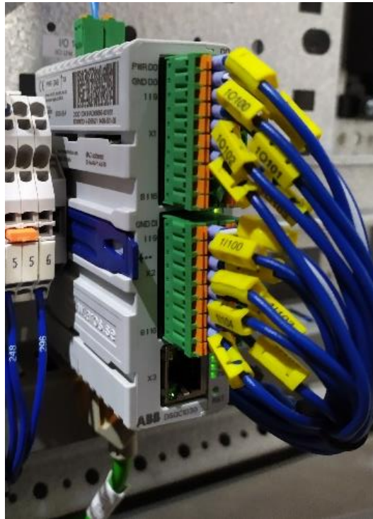
Figura 45 - Módulo DSQC 1030 de entradas e saídas digitais.
