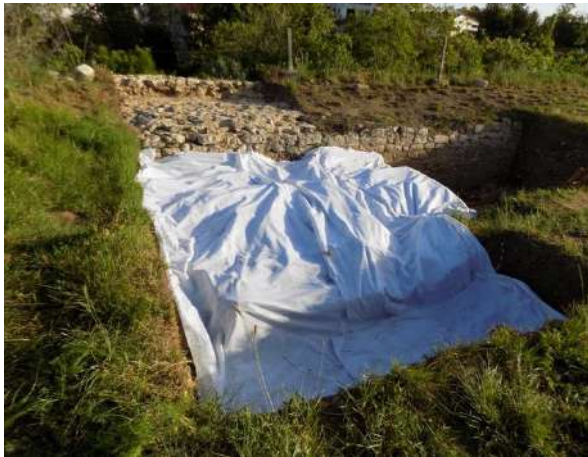
Sondagem FXVII.16.11 – Colocação manta geotêxtil
