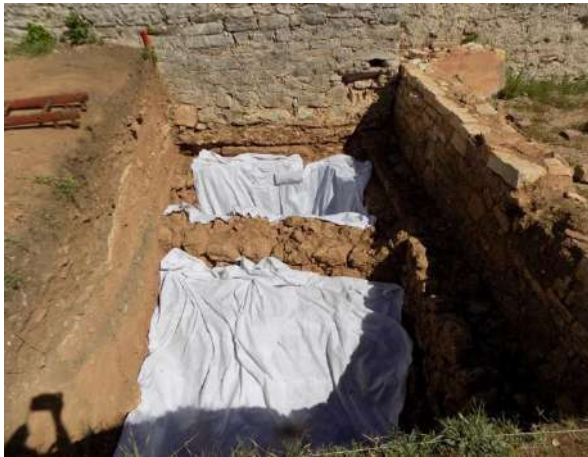
Sondagem GXVII.31 – Colocação manta geotêxtil
