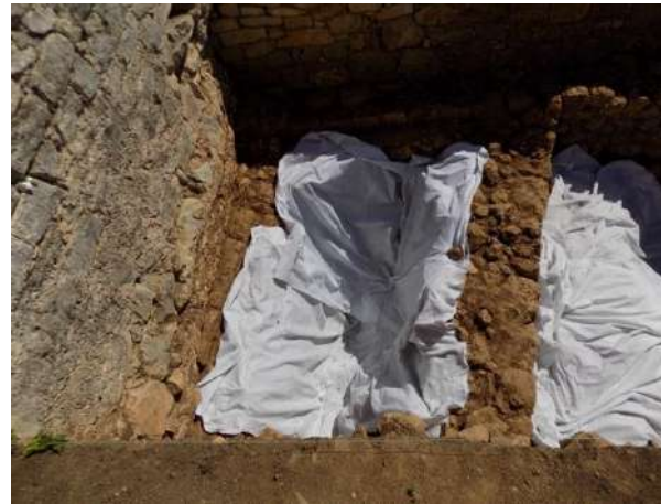
Sondagem GXVII.31 – Colocação de manta geotêxtil.
