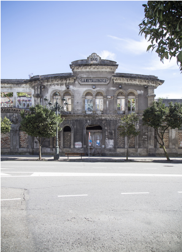
▲ Fig. 046. La Metalúrgica. Arenal. Estado actual de la fachada.
