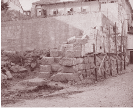
Rua Postigo dos Manos. Aspecto das obras realizadas pela DGMEN.
