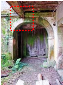
Fig. 53 – Apoio da galeria sobre a arcada
