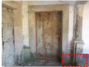
Fig. 95 – Acesso à galeria
