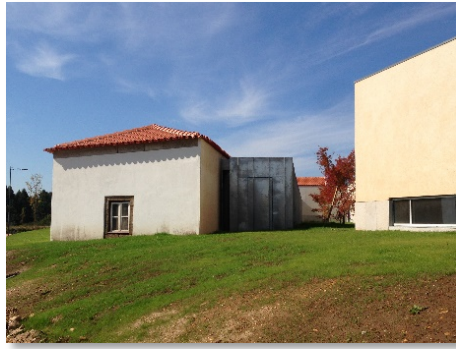
Fig. 36 – Galeria de acesso ao setor administrativo
