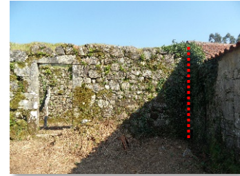
Fig. 59 – Encontro das paredes
