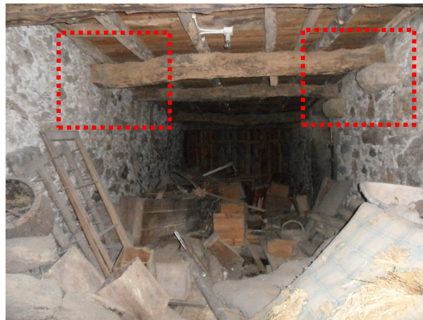
Fig. 91 – Apoios nas paredes do piso inferior – Corpo poente
