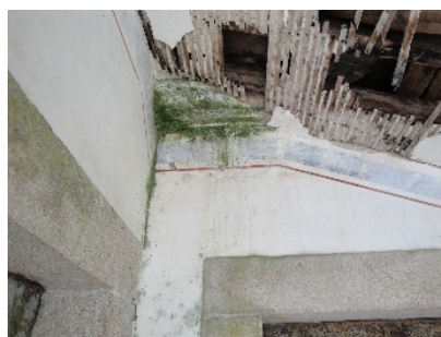
Fig. 67 – Cornija que atravessa a estrutura do alpendre
