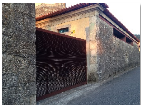
Fig. 18 – Novos vãos rasgados na fachada sul
