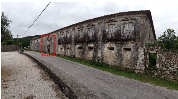
Fig. 77 – Acesso de serviço – Fachada poente
