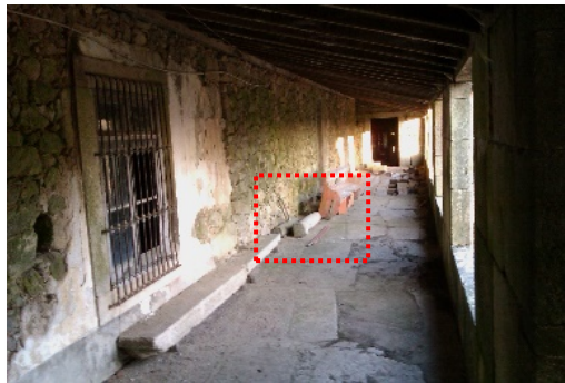
Fig. 84 – Colunas encontradas no local
