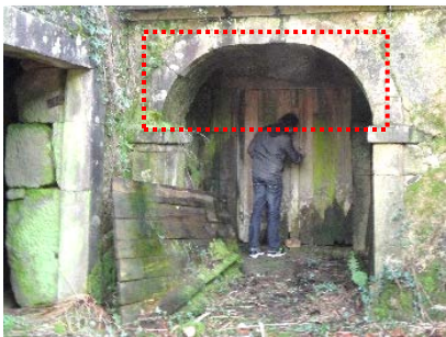
Fig. 65 – Fotografia geral dos apoios do patamar
