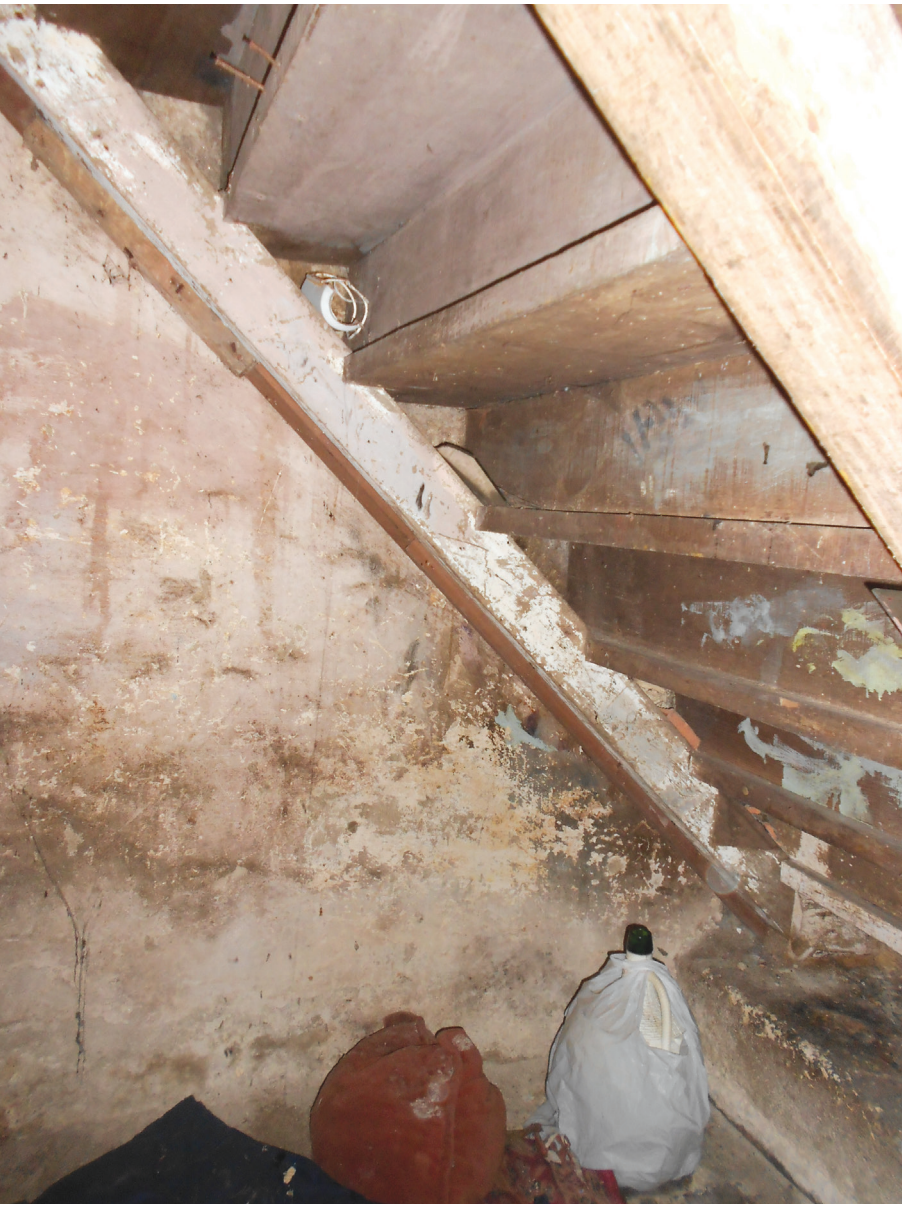
FIG. 58 HABITAÇÃO 8 – PARTE INFERIOR DAS ESCADAS INTERIORES DE ACESSO À HABITAÇÃO 4
