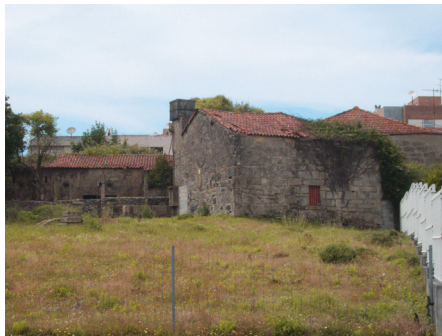
FIG. 46 VISTA PARA A PRÉ-EXISTÊNCIA ANTES DA AMPLIAÇÃO DA ESCOLA
