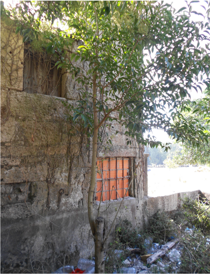
Q1 VISTA DA FACHADA NOROESTE
