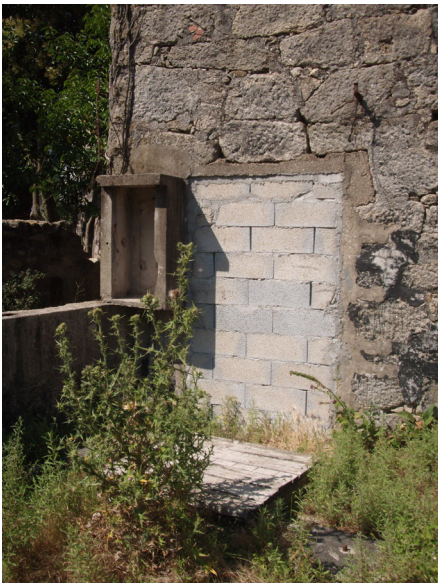
Q2 VISTA DE UM VÃO INTERIOR
