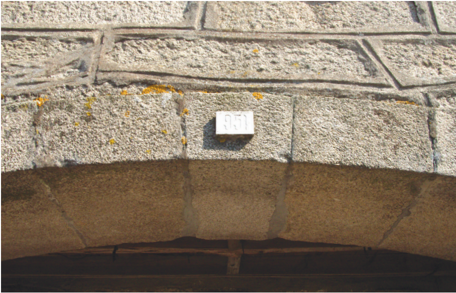
FIG. 56 FACHADA NORTE - PREENCHIMENTO DAS JUNTAS NA ALVENARIA.
