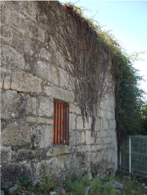
Q7 VISTA DE VÃO EXTERIOR NA FACHADA SUDESTE
