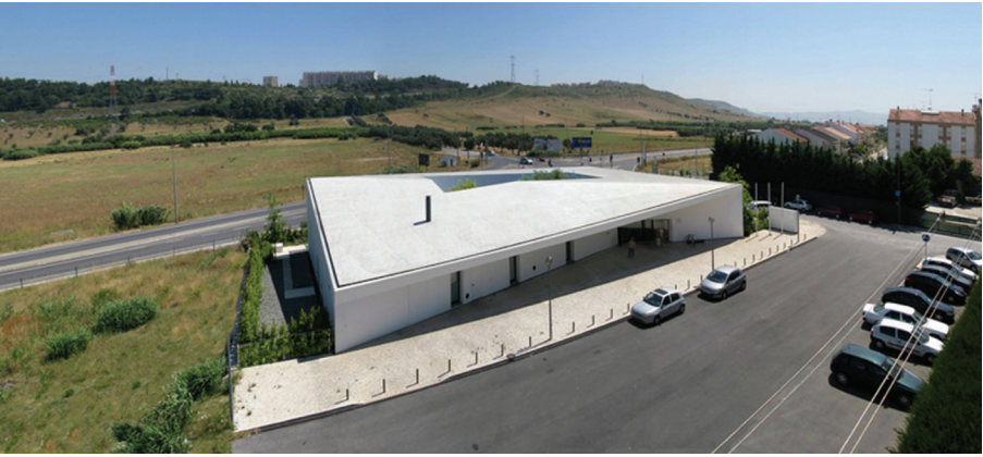
FIG. 9 VISTA AÉREA | CENTRO DE DIA DE VIALONGA. PORTUGAL, MIGUEL ARRUDA
