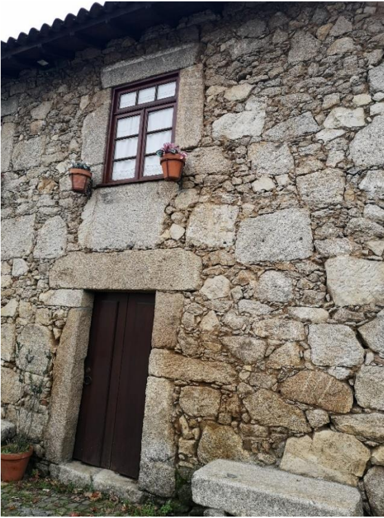
Figura 44: Casa dos Lagareiros da antiga Quinta de Gião; Fonte: do autor
