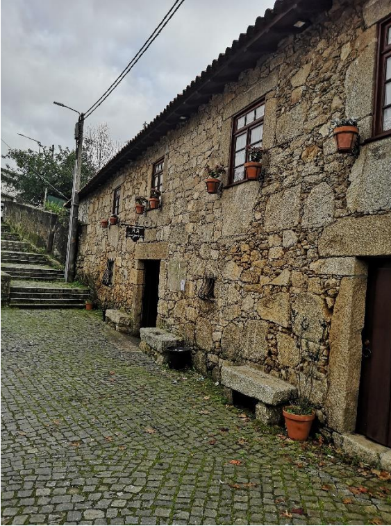
Figura 4: Fachada da antiga casa dos lagareiros da extinta Quinta de Gião; Fonte: do autor
