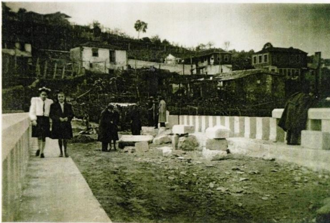
Figura 60: Ponte Nova em Construção; Fonte: Cedido por Augusto Soares (2020)
