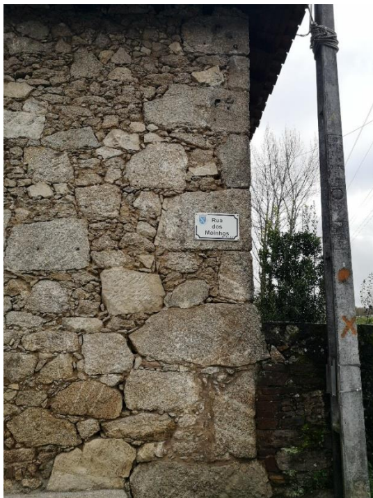
Figura 46: Pormenor da sinalética do nome atual da rua onde se localiza a casa dos lagareiros da antiga Quinta de Gião; Fonte: do autor
