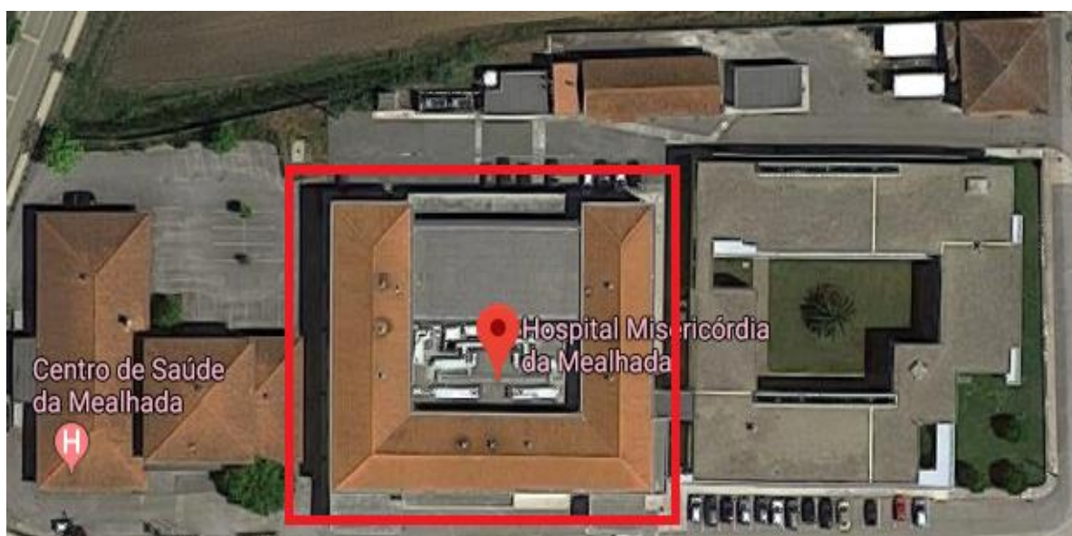
Figura 1.1 – Vista Aérea do edifício (Google Maps)
