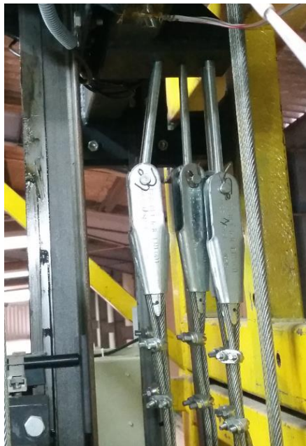
Figura 54 - Variação de verticalidade dos amarra-cabos no suporte
