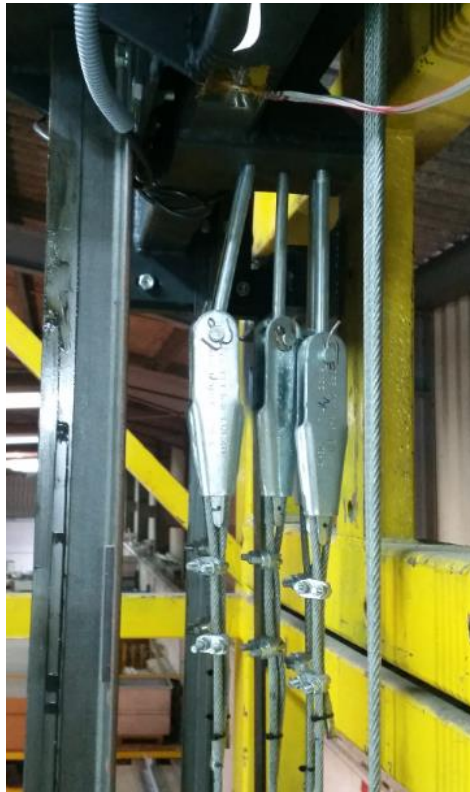
Figura 8 - Fixação de cabos no suporte
