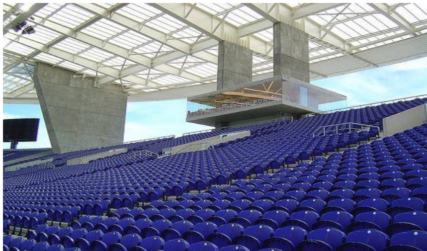
Figura 14 – Sala de controlo do Estádio do Dragão, com vista para o recinto de jogo (Fonte: http://www.marcofcastro.net/as-assistencias-ao-jogos-do-fc-porto-aspectos-a-relfectir-e-solucoes-a-considerar/ )
