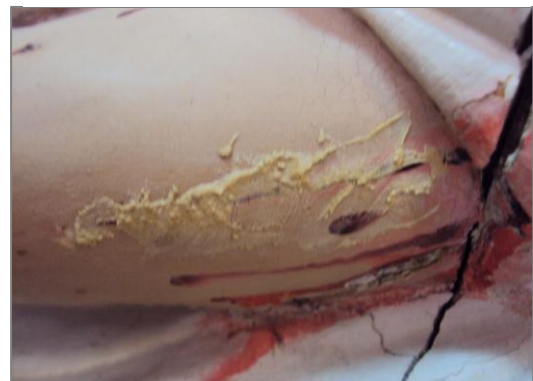
Fig.61 Massas de preenchimento amarelas na base.
