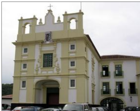
Fig.10 – Capela de Nossa Senhora dos Remédios
