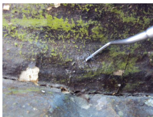
Fig.97 Remoção de estearina na base.
