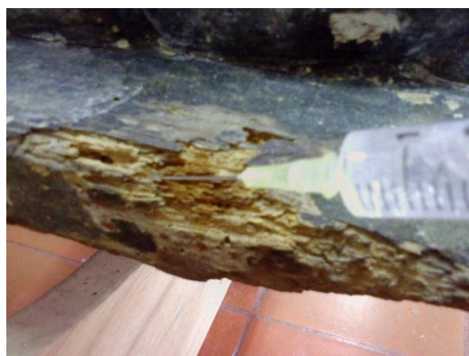
Fig.101 Imunização na base.
