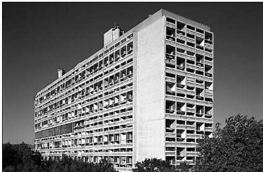
Fig. 50: La Unidad Habitacional de Le Corbusier, Marseilles.
