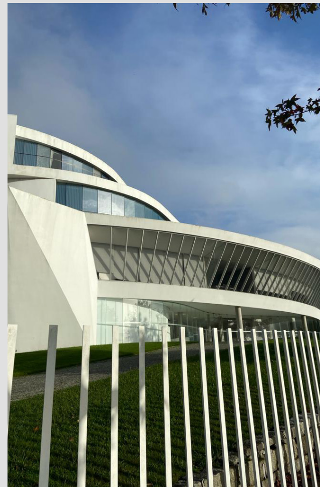
FIGURA.2: edifício do CEiiA
