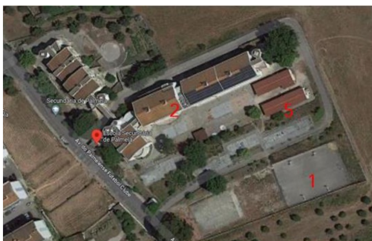
Figura 3- Vista aérea da ESP
