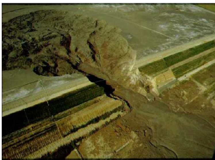
Figura 3.18-Cedência da barragem de resíduos (ouro) em Merriespruit, África do Sul, por liquefação por fluxo em Fevereiro de 2004 (Souza, 2018).
