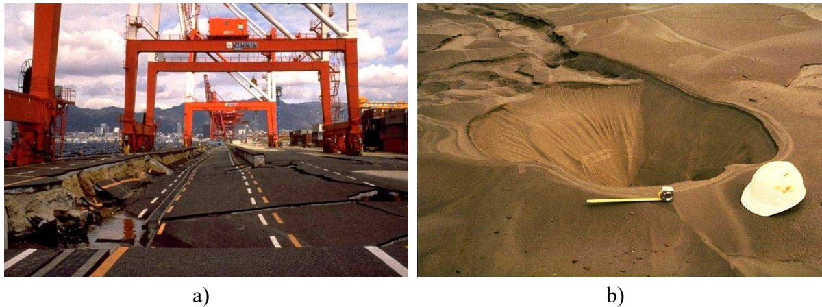
Figura 3.21-Danos devido à mobilidade cíclica (Johansson, 2000): a) deslocamento lateral dum muro cais em Port Island, resultante do sismo de Kobe; b) vulcões de areia devido à liquefação induzida pelo sismo de Loma Prieta em Area Bay.
