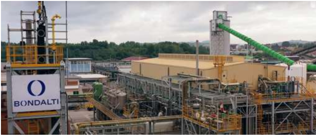
Figura 42: Complexo industrial da Bondalti em Estarreja
