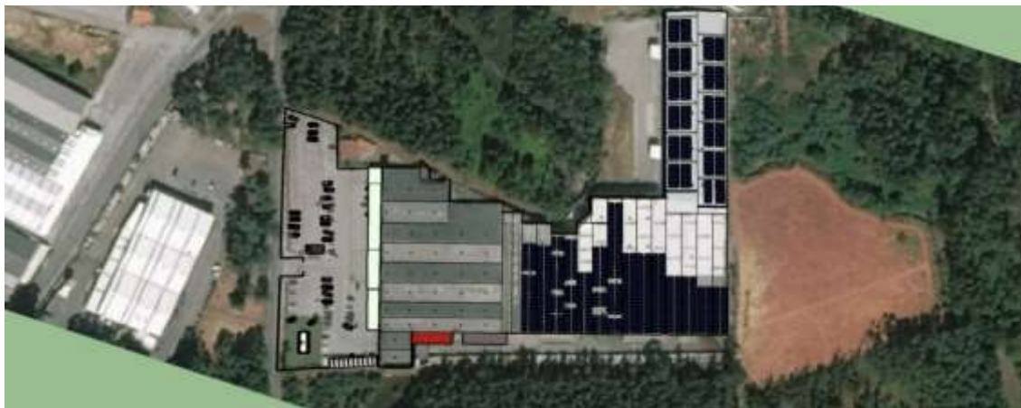
Figura 6.13 – Vista aérea da cobertura com os módulos fotovoltaicos
