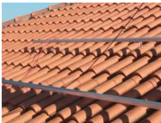
Figura 6.5 – Estrutura de suporte caso de estudo 1
