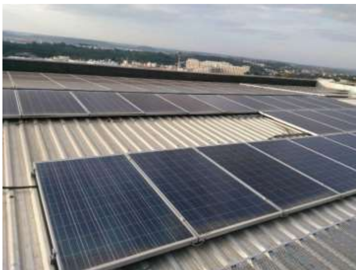
Figura 5.23 – Instalação estrutura fotovoltaica
