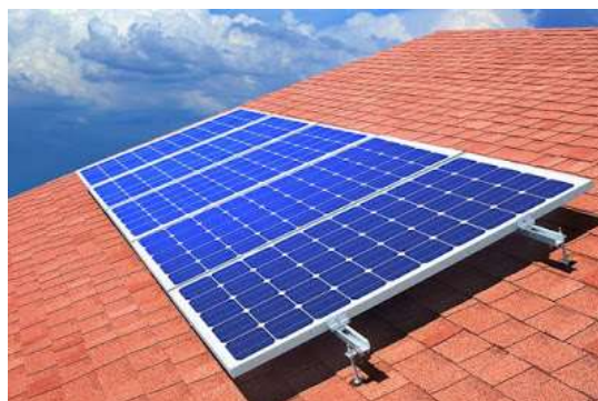
Figura 5.17 – Painéis fotovoltaico em cobertura de telha (Ambiente Energia, 2017)
