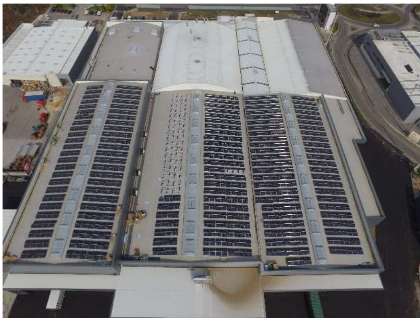
Figura 6.37 – Instalação dos módulos monocristalinos (SunEnergy, 2018)
