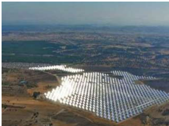
Figura 3.4 – Central fotovoltaica Hércules (Portugal Bipolar, 2014)
