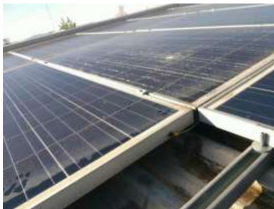
Figura 6.46 – Reparação painel fotovoltaico avariado
