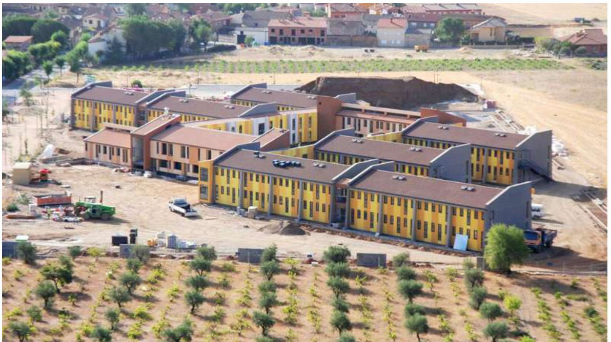
Fig. 26. Centro social de convivencia para Mayores Trabensol. 2002. Modelo Co-Housing. Fuente: https://trabensol.org
