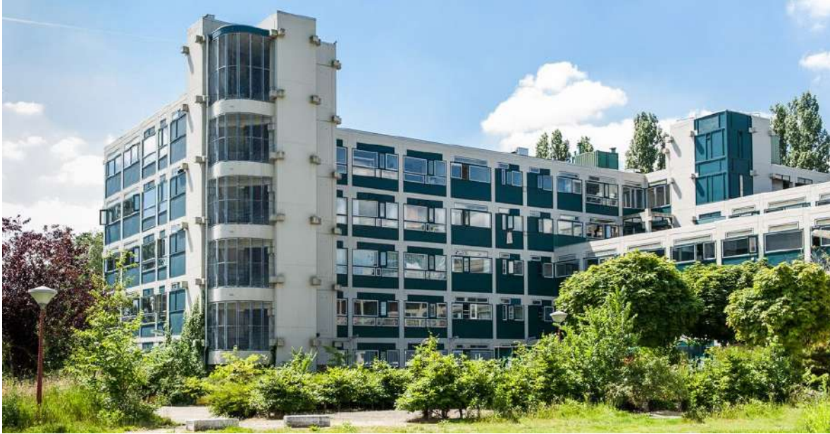
Fig. 79. Jardines en la planta a ras de suelo. Fuente: Man protection bv
