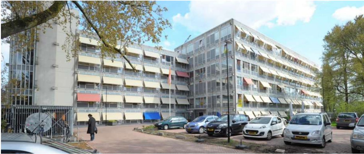
Fig. 66. Aspecto exterior del edificio con grandes ventanas y elementos de protección solar.
