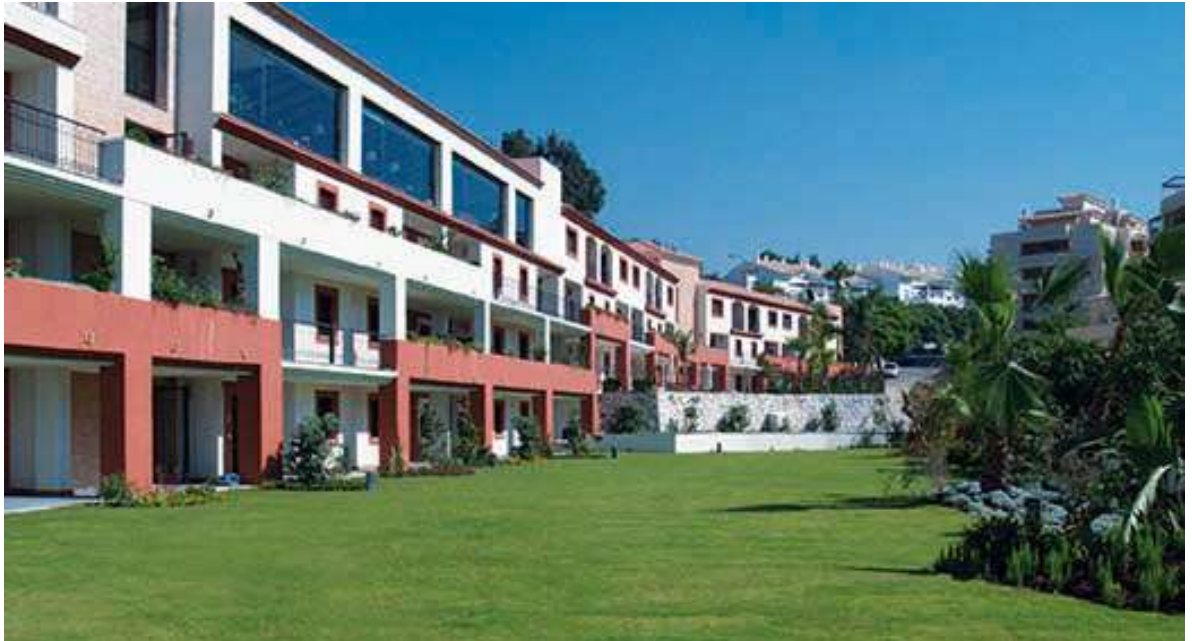
Fig. 29. Viviendas con servicios ADOREA. Girona. Fuente: www.domusvi.es
