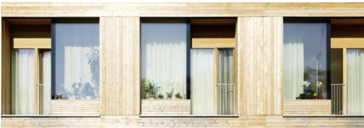
Fig. 116. Ventanas y balcones de las habitaciones. Fuente: www.archydaily.com
