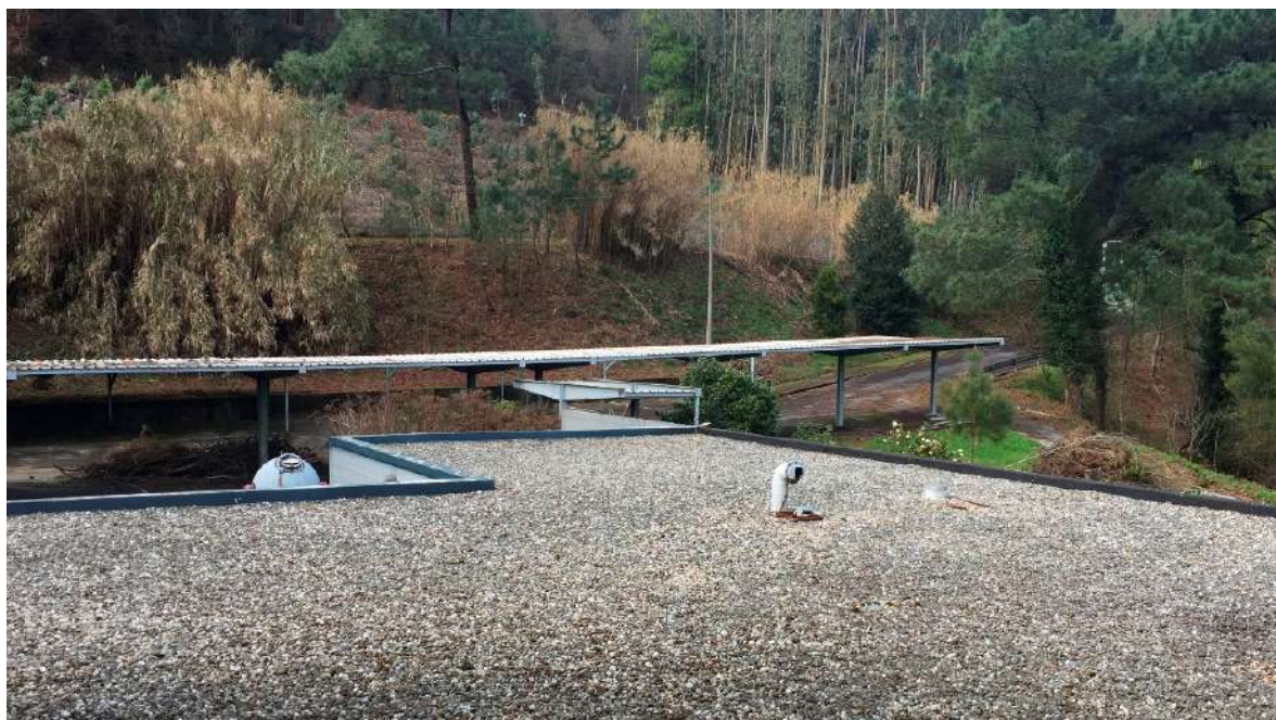
Fig. 23. Cubierta plana actual. Fuente: Autor
