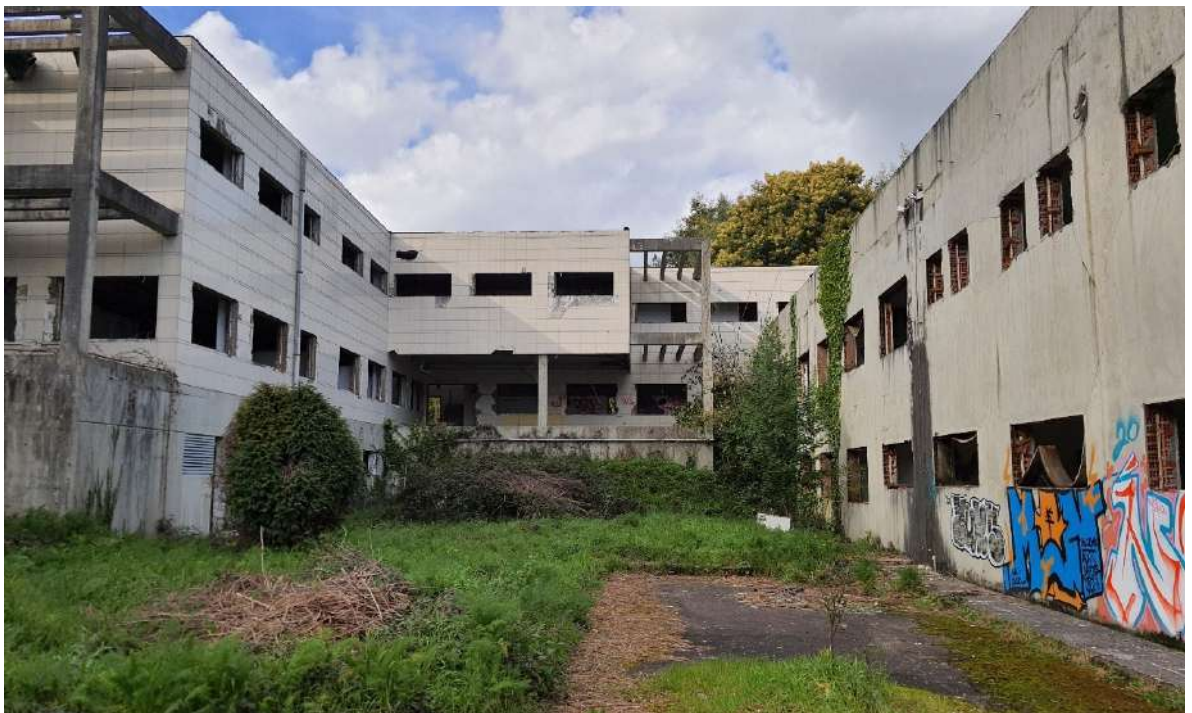
Fig. 188. Estado actual de edificio. Fuente: Autor
