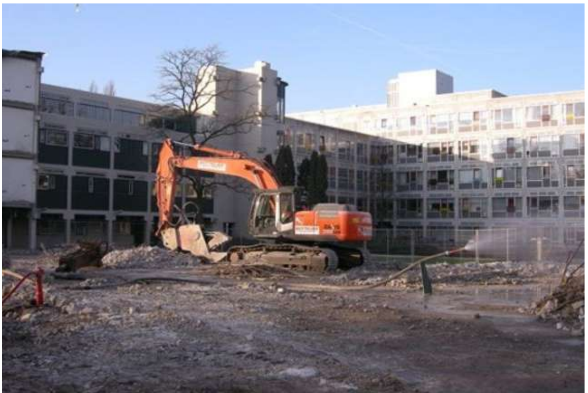
Fig. 98. Demolición parcial del complejo en 2011. Fuente: Het Parool
