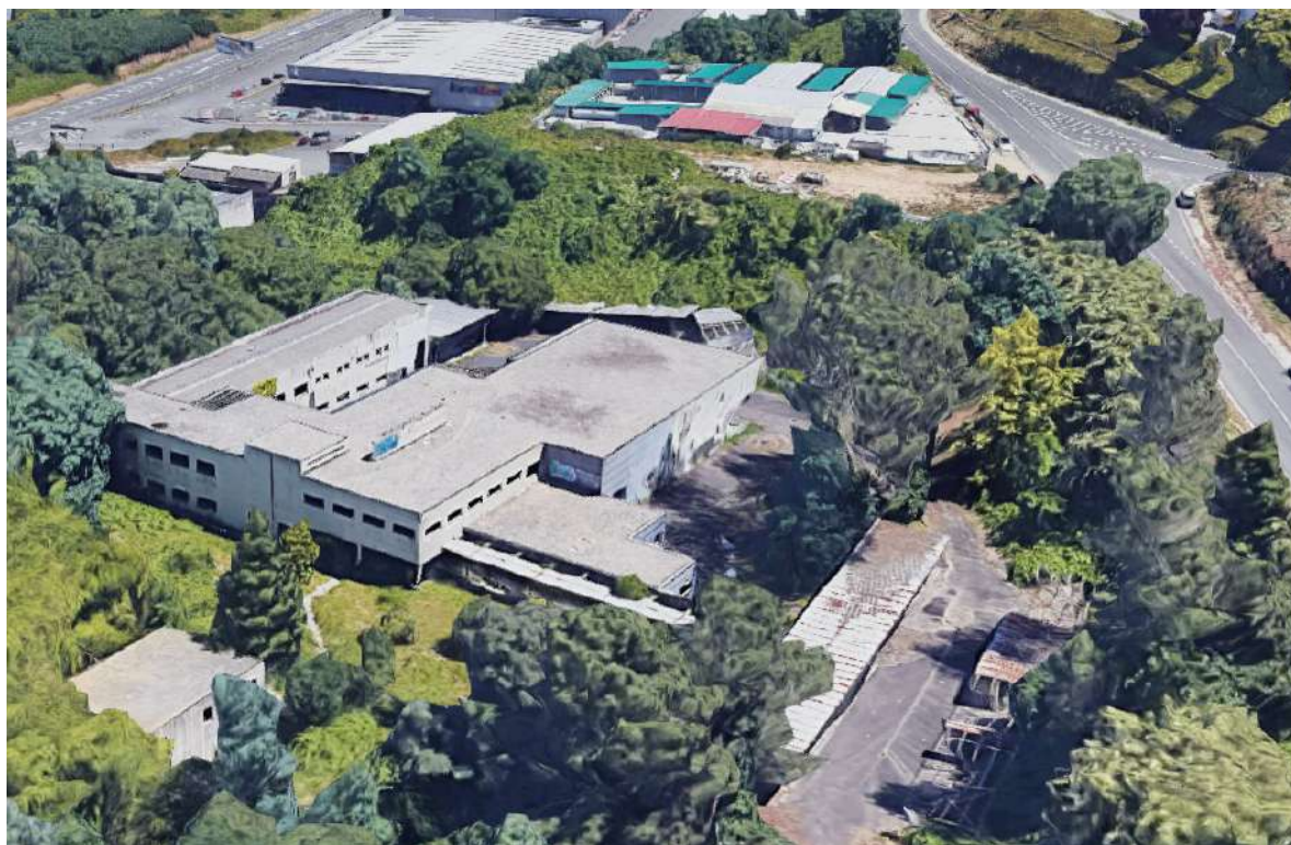
Fig. 190. Vista aérea del edificio existente en sus fachadas norte y oeste. Fuente: Google maps
