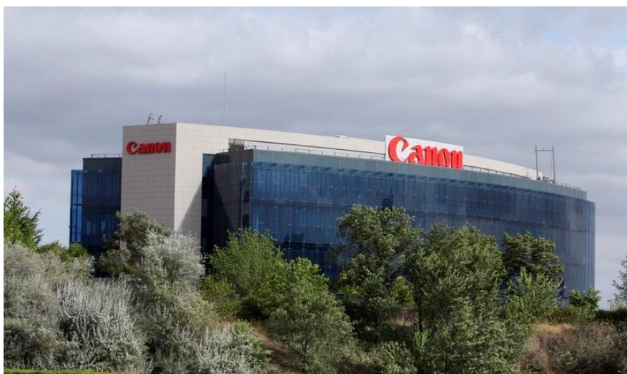
Fig. 27 – Edifício sede da Canon España S.A. (KNX Association, n.d.)
