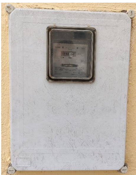
Figura 5 - Caixa de contagem de instalação monofásica com potência de 5,75 kVA
