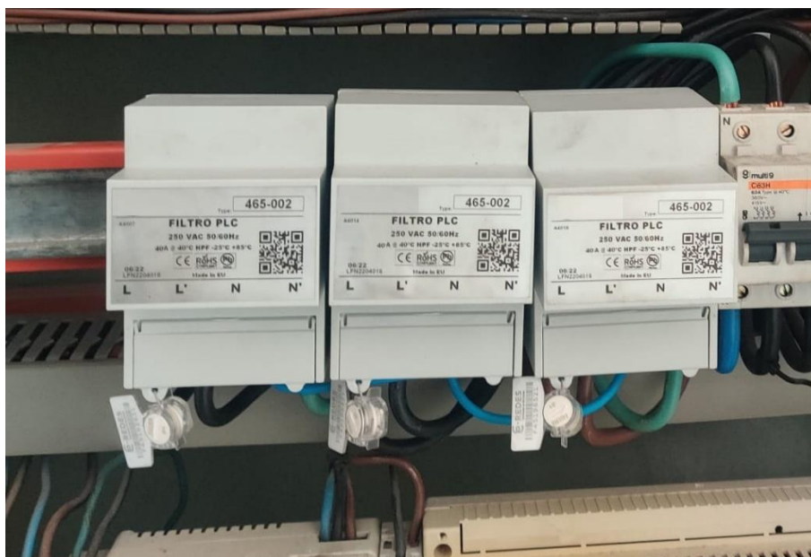
Figura 86 - Instalação dos três filtros de 40 A na loja de tecidos
